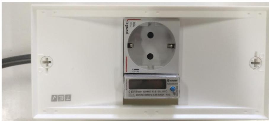
Figura 18 - Medidor de consumo elétrico FINDER 7E.64.8.230.0010.
