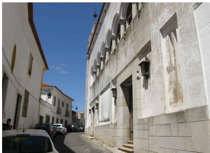
Fig. 2 – Salão Central Eborense. Fachada sul.
