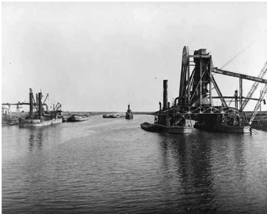
Fig. 4: image des années 1920 pour la construction de la nouvelle zone industrielle. En particulier : des dragues en action pour l'excavation des canaux desservant la zone industrielle.
