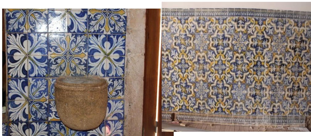
Figura 29 - A primeira e segunda fase da decoração com os azulejos de padrão 4 (restauração de 1970) e padrão 9 (restauração de 2020) (Claudino Borges 2020).
