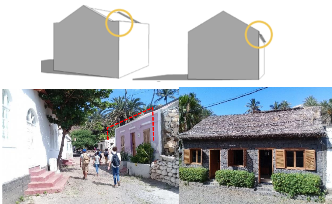
Figura 45- Cobertura com platibanda e beirado (fonte: Cidade Velha Guia de normas urbanísticas e fotografia Claudino Borges, 2018).
