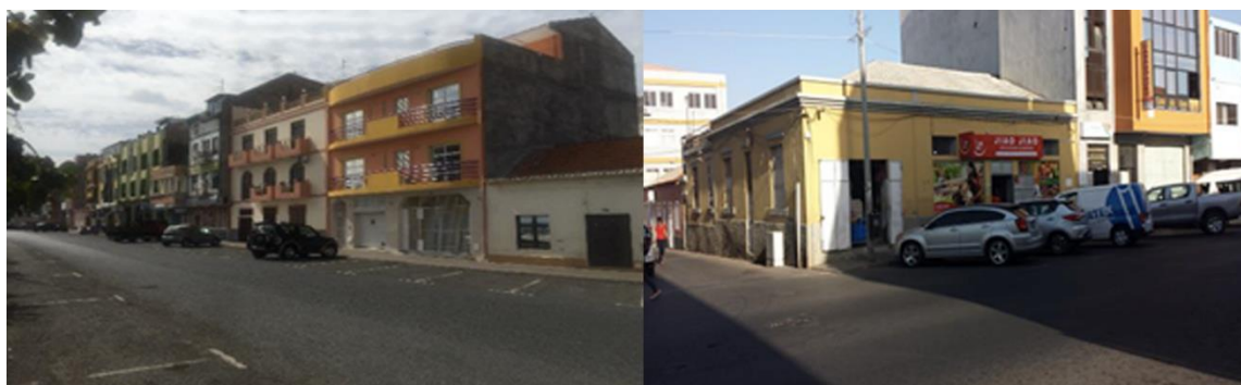
Figura 11-Alterações do sistema arquitetónico alargamento e asfaltagem das ruas no centro histórico da Praia (Claudino Borges, 2018)
