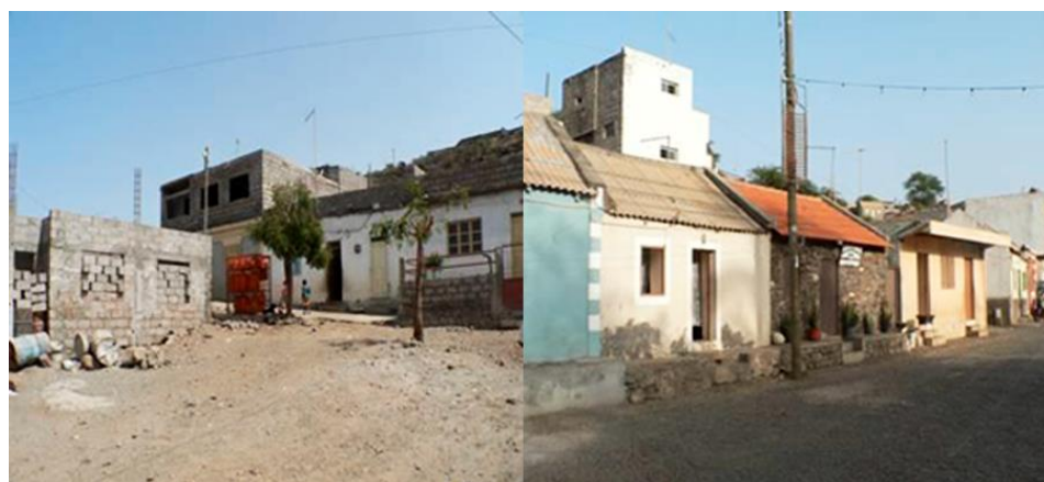
Figura 16- A edificação dos edifícios do 1º piso no centro histórico da RGS (IPC 2012).
