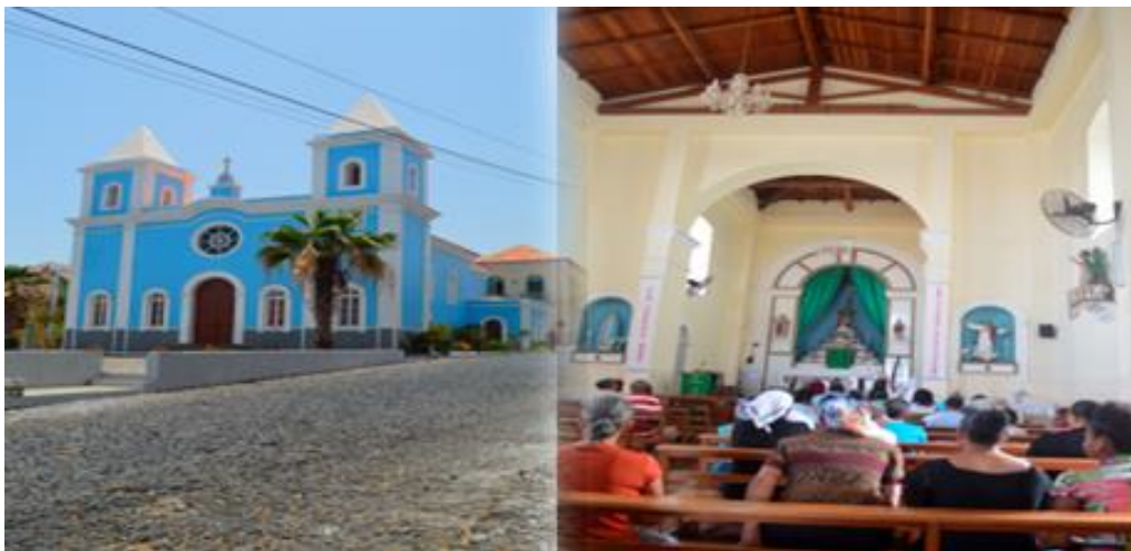
Figura 60- Vista frontal e lateral, altar-mor e tipo de cobertura da igreja de Nossa Senhora da Conceição – Centro histórico de São Filipe (Claudino Borges, 2017)
