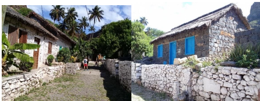
Figura 43- Fachadas de pedras basálticas aparentes e caiadas (Claudino Borges, 2018).
