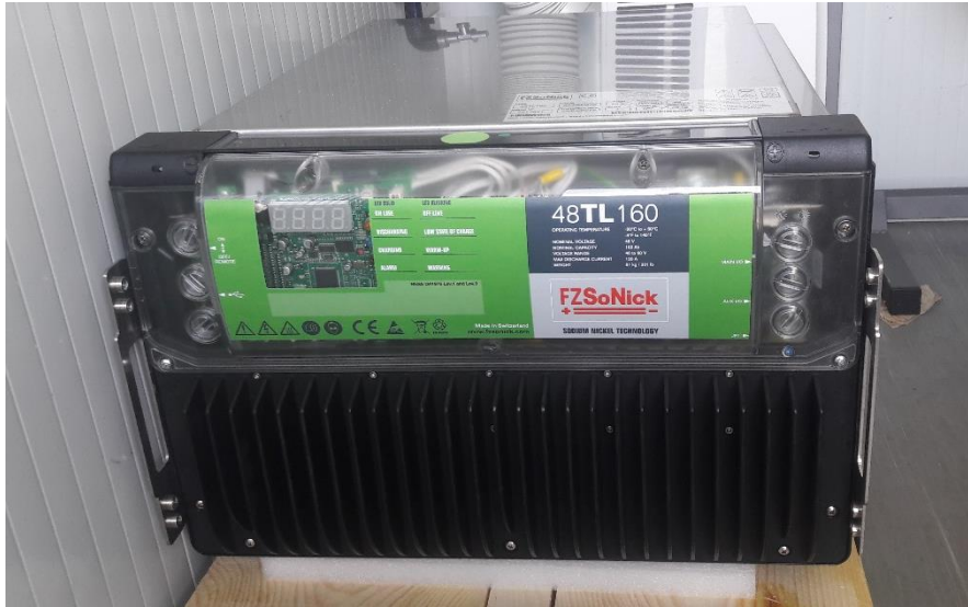
Figura 20. Bateria de cloreto de sódio-níqueu/ZEBRA FZSoNick 48TL160 utilizado na instalação.
