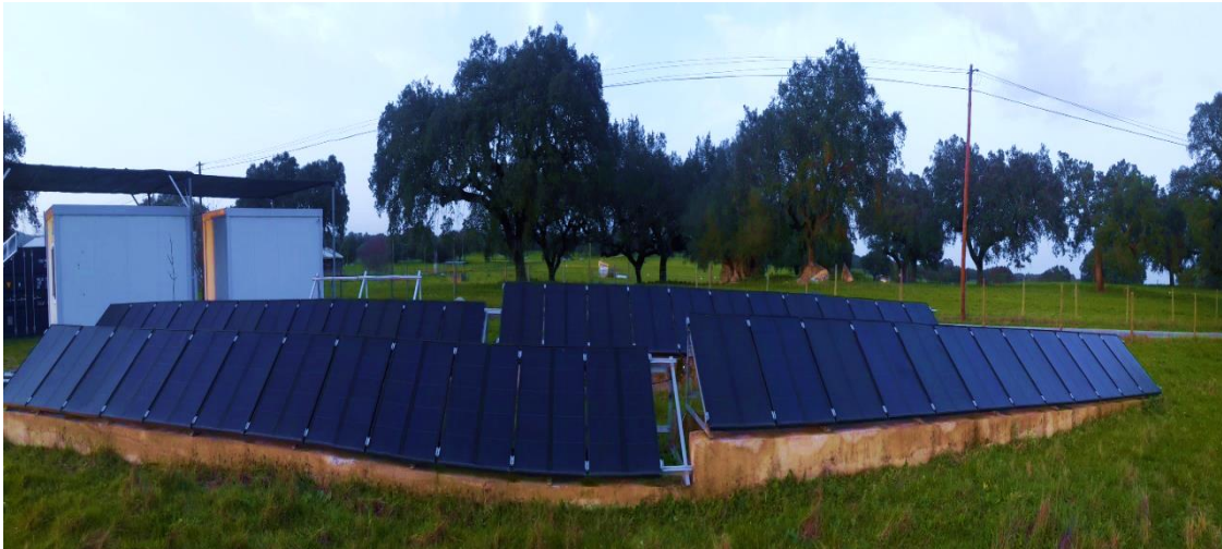
Figura 22. Instalação fotovoltaica de 3.224 kWp na plataforma de ensaios de baterias na Cátedra de Energias Renováveis da Universidade de Évora.
