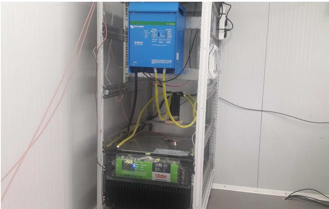
Figura 24. Bateria ZEBRA e o inversor MultiGrid instalado na IU na plataforma de ensaios de baterias.
