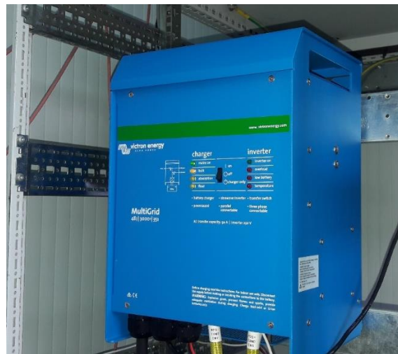
Figura 17. O inversor bidirecional MultiGrid 48/3000/35-50 da Victron Energy utilizado na instalação.
