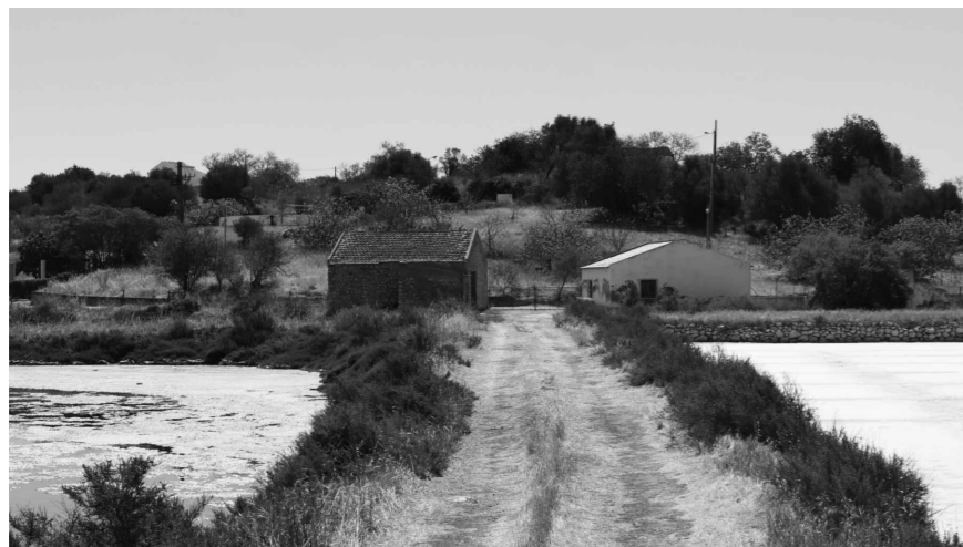
fig. 165 Vista do interior para a entrada, Mexilhoeira da Carregação, 2019.
