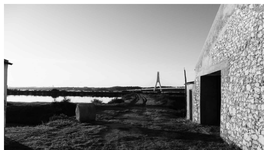
fig. 167 Vista da entrada, Mexilhoeira da Carregação, 2019.
