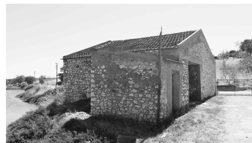
fig. 171 Armazém de Sal, Vista do interior, Mexilhoeira da Carregação, 2019.
