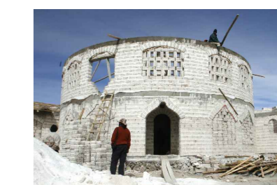
fig. 027 Construção de um hotel em blocos de sal no Salar de Uyuni, o maior deserto de sal do mundo, no sudoeste da Bolívia, 2007. © Jose Luis Quintana
