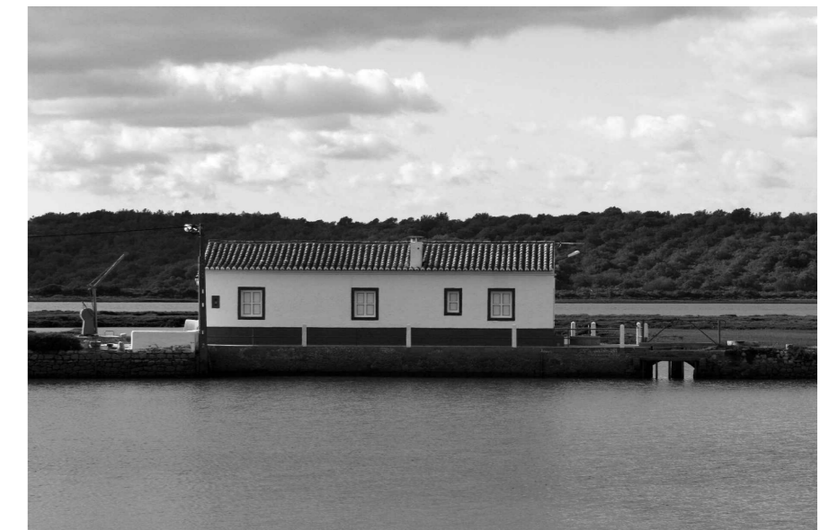
fig. 162 Moinho de Maré reabilitado, Mexilhoeira da Carregação, 2019.
