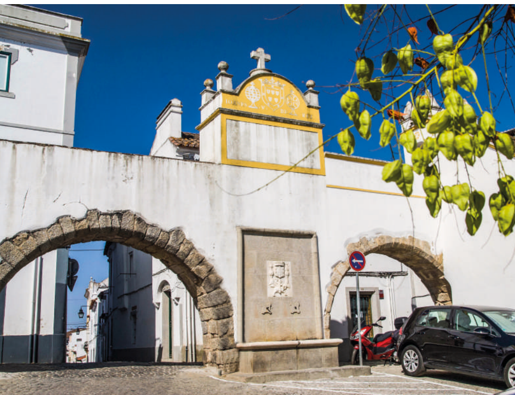
Aquaduto da Água da Prata no Largo do Chão das Covas.
