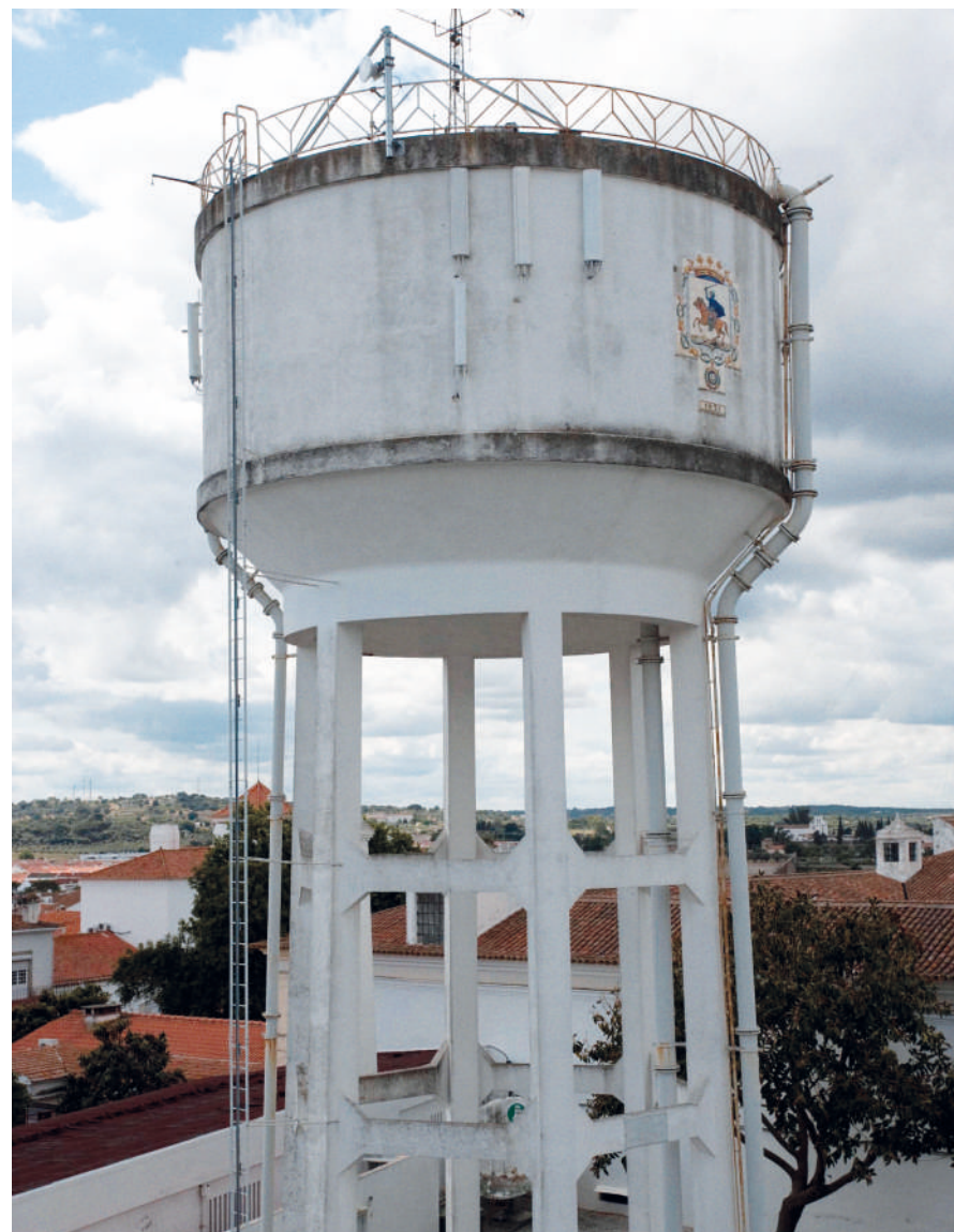
Reservatório de serviço regulador de distribuição de água
