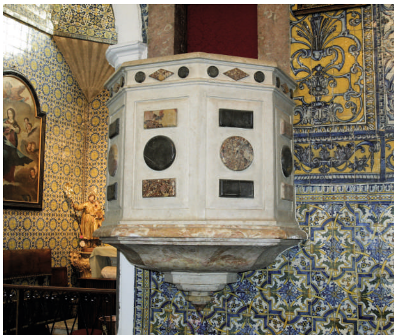
Igreja de São Mamede, púlpito em Lioz com ornamentos de Brecha da Arrábida e Calcário Negro de Mem Martins. Observam-se ainda as ombreiras da porta de acesso em Lioz variedade Encarnadão.
