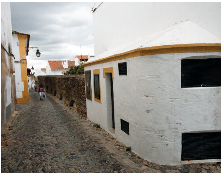
Camãra de manobras localizada na Travassa do Serpe.
