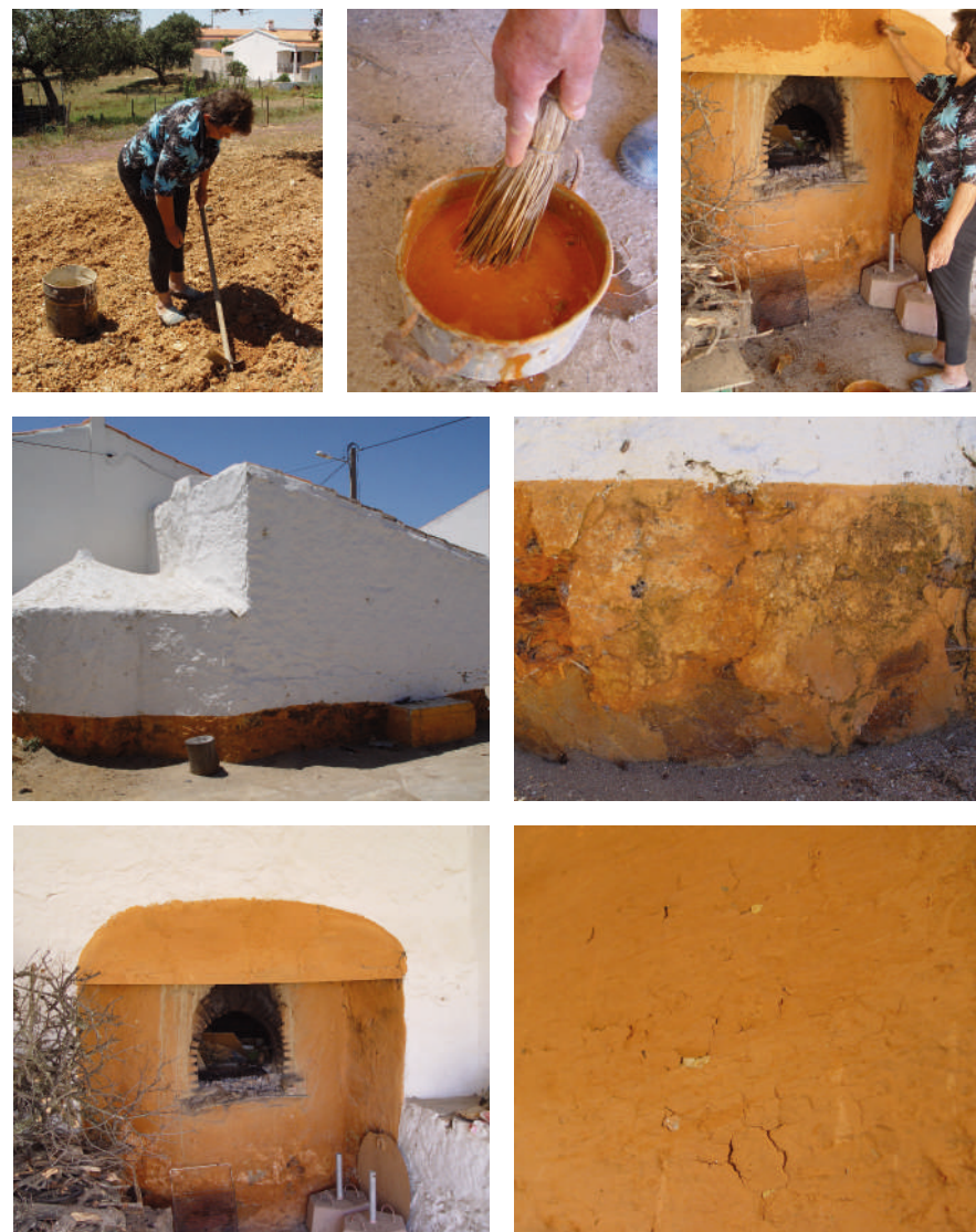
Exemplo de duas caiações com consistências opostas realizadas com a mesma terra corada, preparadas e estendidas pela mesma executante em Monte Poço Barbas nas redondezas da Mina de S. Domingos.
