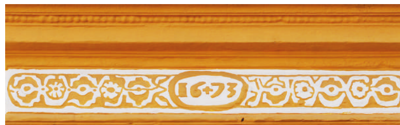
Rua Vasco da Gama 18
