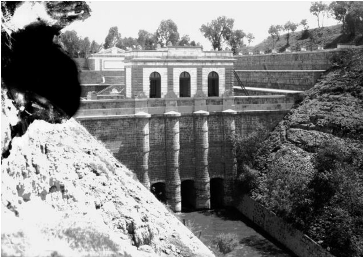
**Figure 31. Barrage et vannes du tunnel de Tequixquiac, ca. 1910.**
