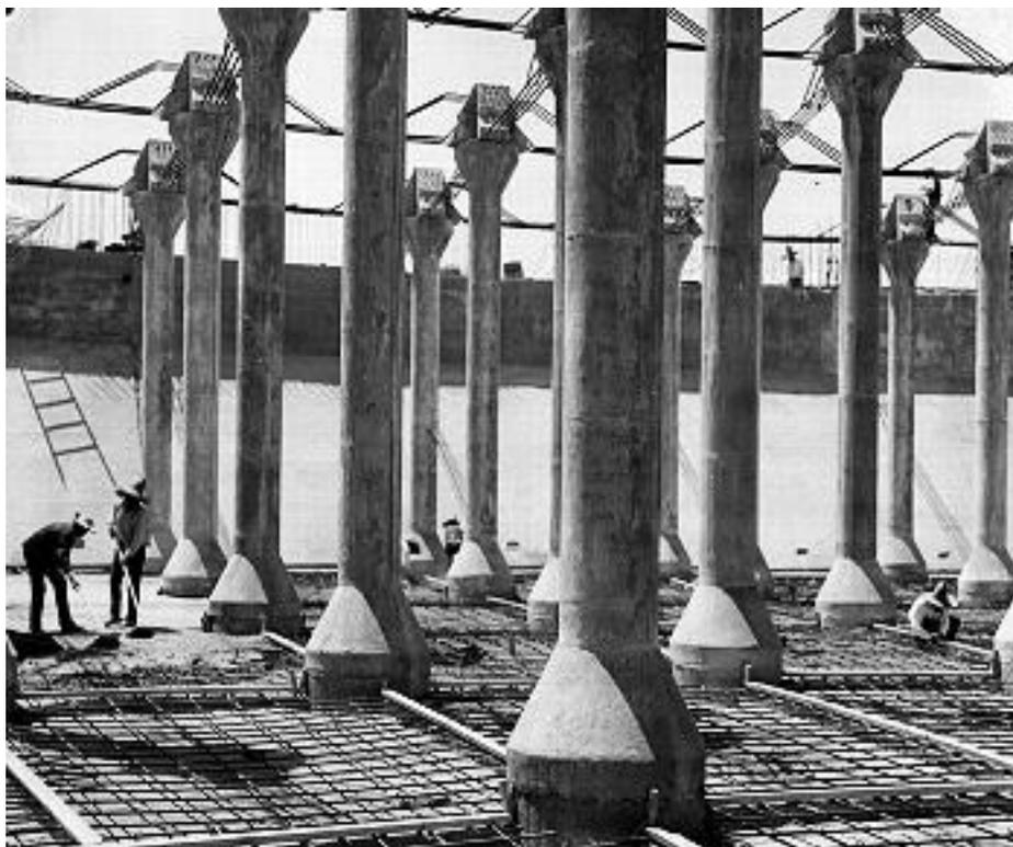
**Figure 45. Construction d'un des réservoirs de Dolores.**
