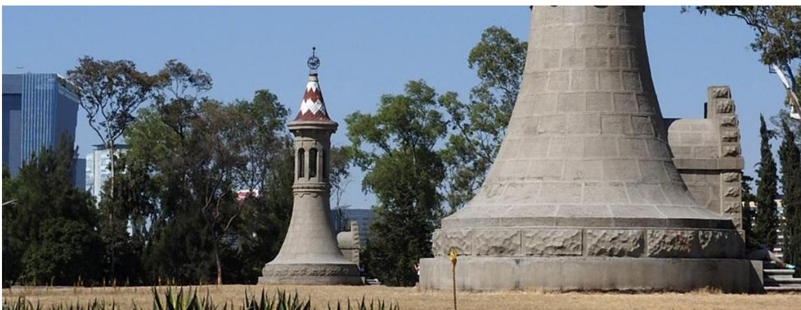
**Figure 30. Cheminées de ventilation réservoirs de Dolores.**
