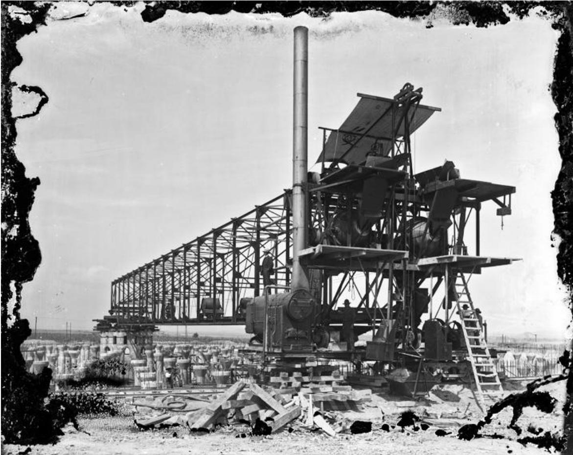
**Figure 49. Pont tournant utilisé pour la construction des réservoirs de Dolores, ca. 1909.**
