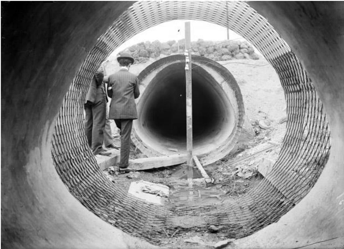
**Figure 46. L'aqueduc de Xochimilco en construction, 1905.**
