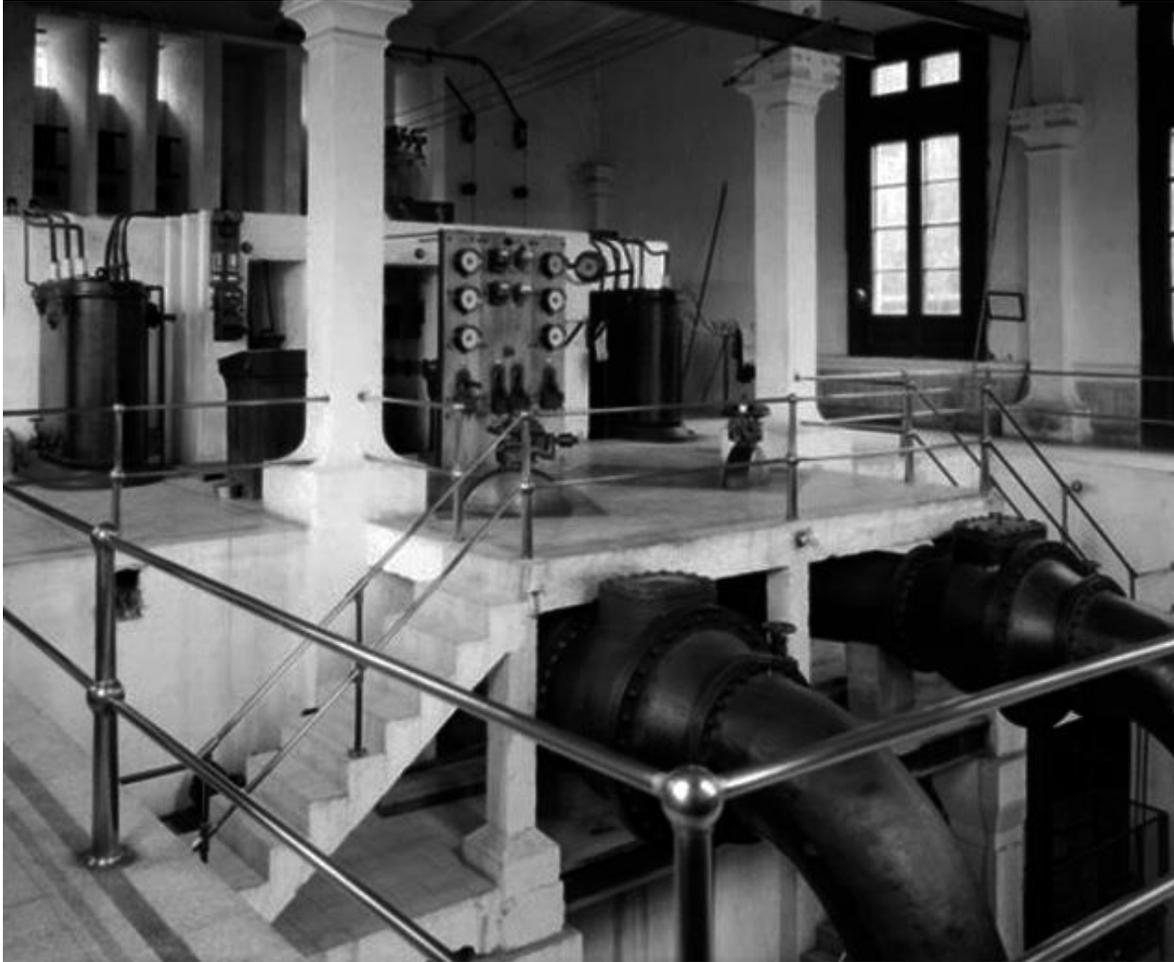
**Figure 51. Machines de pompage électriques de la station San Luis, 1911.**
