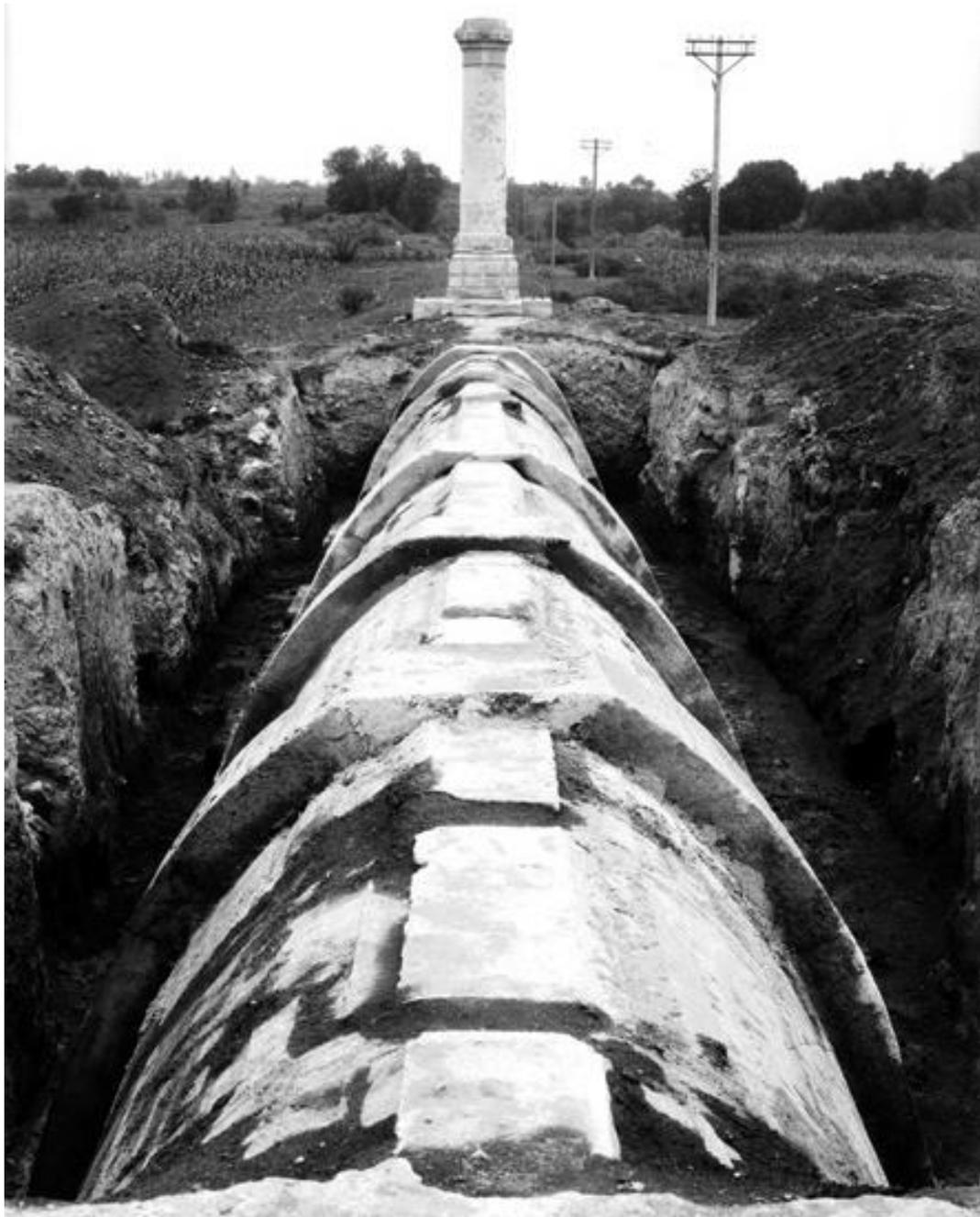
**Figure 26. Canal et cheminée de ventilation de l'aqueduc de Xochimilco, c. 1910.**
