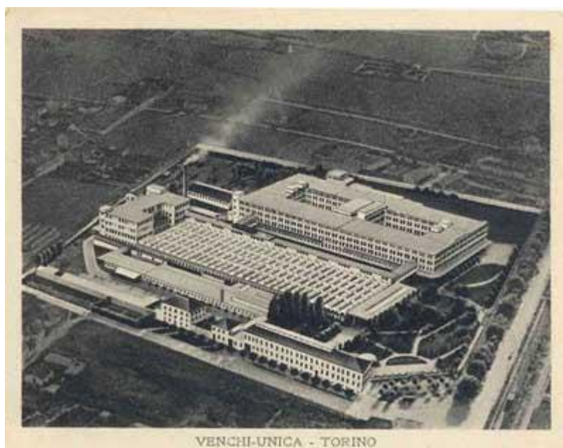
Fig. 2.16. Vue aérienne des nouveaux bâtiments conçus pour la fusion de Venchi et Unica. Source : Archives de la Bibliothèque de Vénice.
