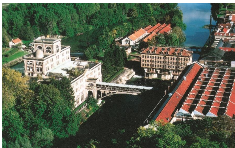
Fig. 2.11 Vue de la « nouvelle chocolaterie » avec, au premier plan, à gauche la « cathédrale » et la passerelle la reliant au bâtiment de dressage ; au second plan, le moulin Saulnier. Source : HISTOIRE : « Les Menier : de La droguerie pharmaceutique à L'industrie chocolatière ». VIEL, Claude.
