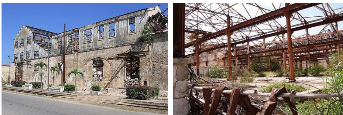
Fig. 4.13. et 4.14 Photographies de l'entrepôt e installations industriels présentes dans le littoral de Cardenas. Source : Daily Barbara Vega Cruz.
