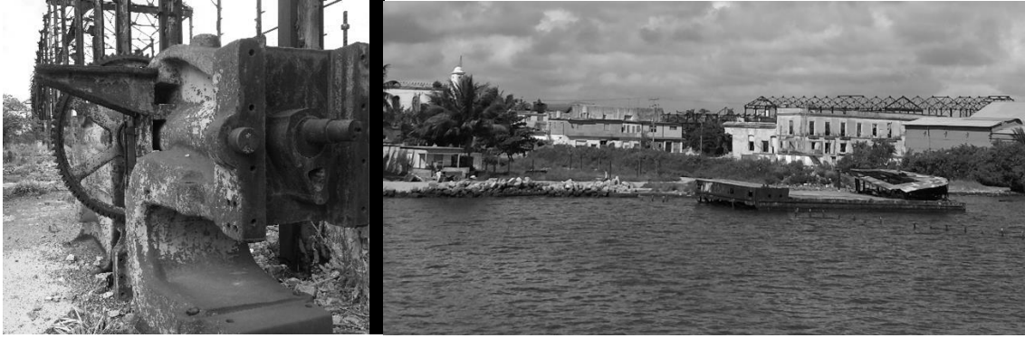
Fig. 3.18 et 3.19. Photographies qui montrent les processus de détérioration présents dans le littoral de Cárdenas. Source : Daily Barbara Vega Cruz.
