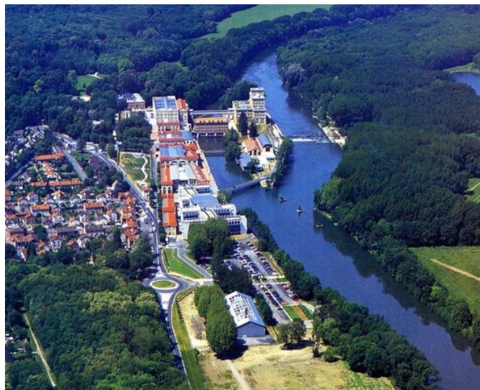
Fig. 2.14 Vue aérienne du site industriel de Menier. Source : www.bernard-garnier.piwigo.com
