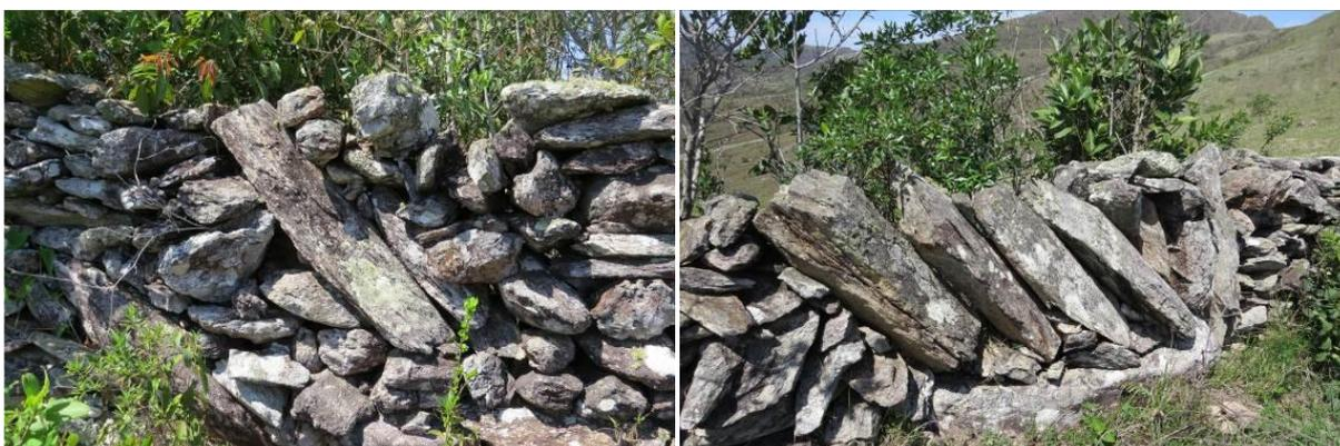
**Foto 22: Forma de posicionamento das pedras no muro escravocrata na Serra do Lenheiro**
