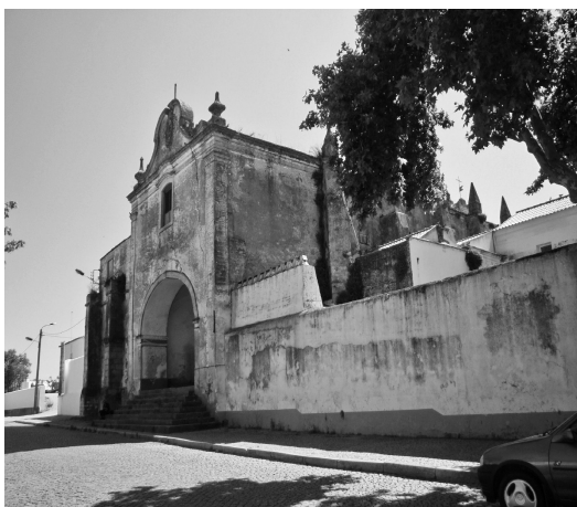
Fig. 14 – Montemor-o-Novo. Vista do alçado principal da igreja do antigo Convento de S. Francisco.
