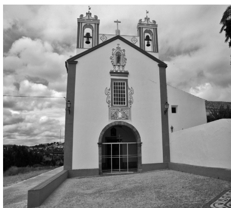
Fig. 24 – Redondo. Vista do alçado principal da Igreja do Convento de S. António da Piedade.
