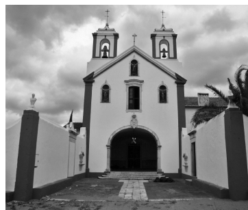
Fig. 33 – Vila Viçosa. Vista do alçado principal da igreja do Convento dos Capuchos.
