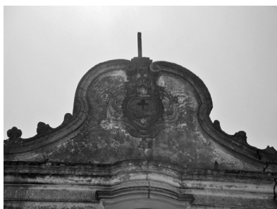
Fig. 13 – Montemor-o-Novo. Vista de um pormenor do remate do alçado principal da igreja do Convento de S. Francisco.
