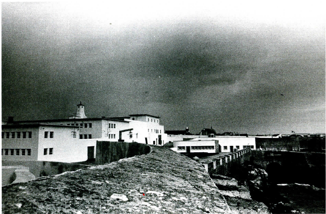
Fortaleza de Peniche onde já são visíveis os novos pavilhões de alta segurança Anos 50 do século XX Câmara Municipal de Peniche
