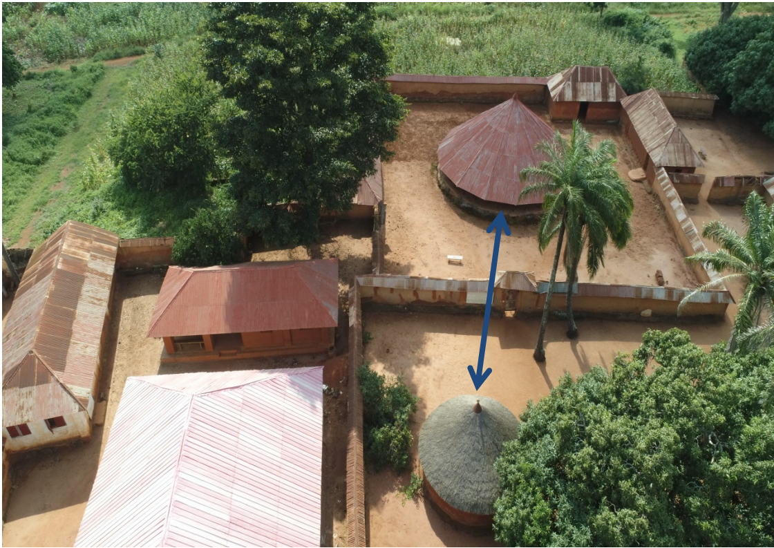
Figure 10: Travaux de restauration de la toiture : la toiture qui était en paille a disparu déjà au profit de la tôle
