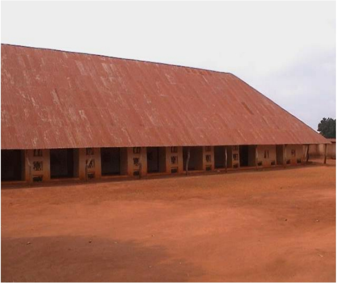
Figure 7: L'un des Cours du palais : salle des trônes reconvertie en musée
