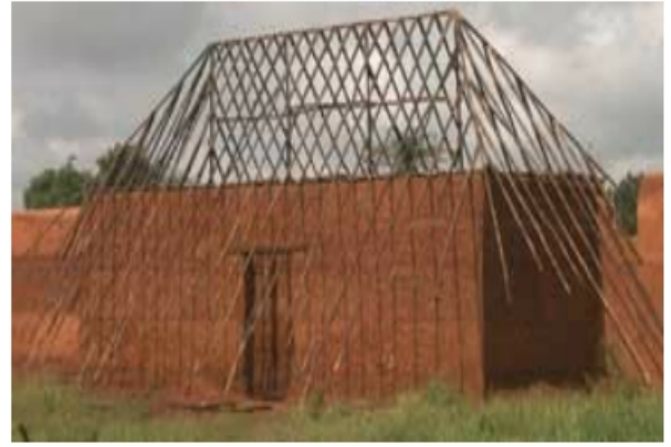
Figure 13: Travaux de restauration du palais.
