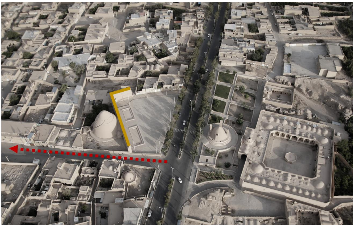
Figure 48: Nouvelle ruelle construite dans la partie est du glacier. (Archives du bureau du patrimoine culturel de ville de Meybod, 25,01,2019).
