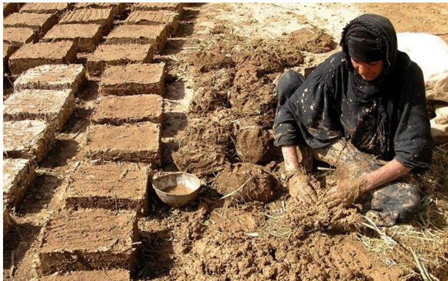
Préparation d'un mélange en ajoutant différents matériaux au sol pour le renforcer, (www.downloadpolitics.com)
