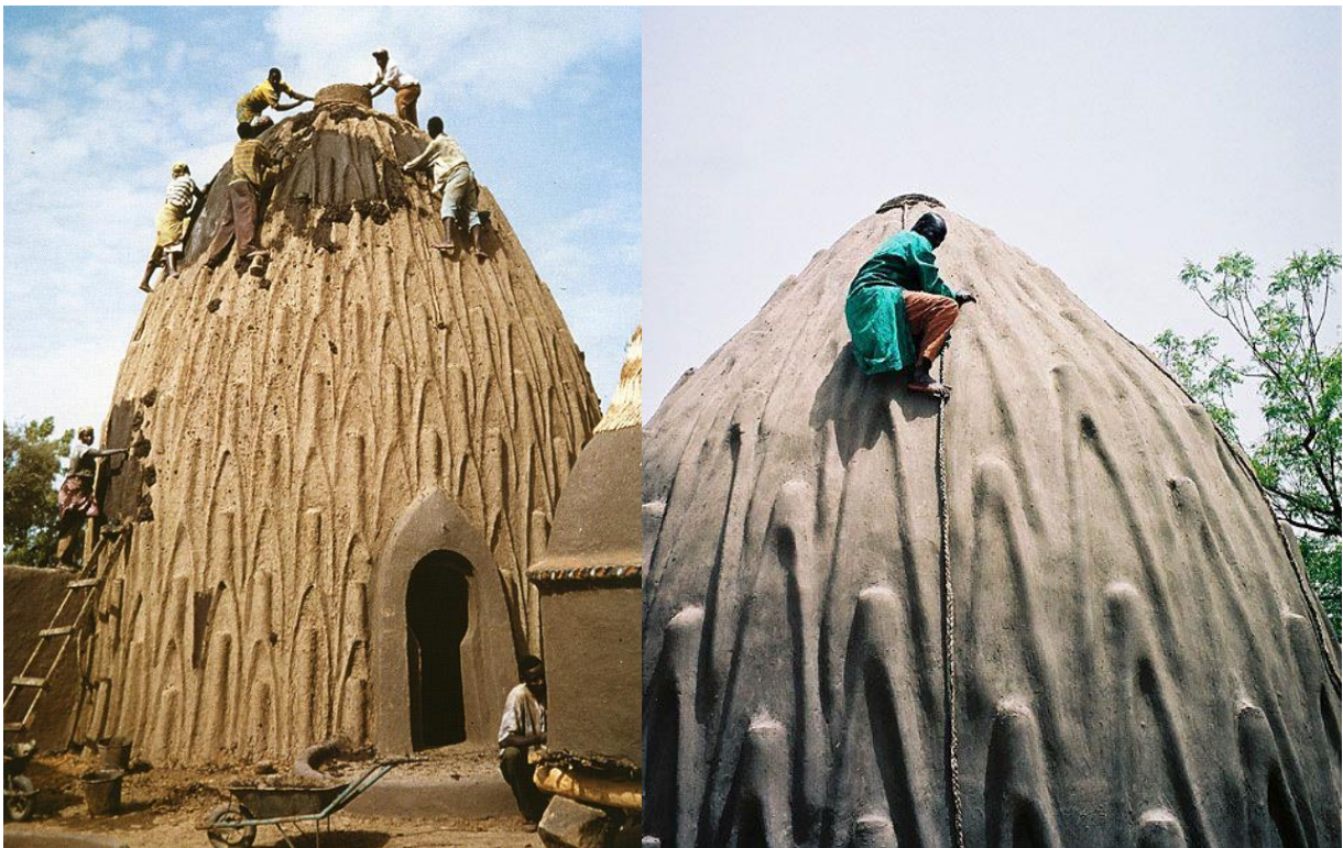
Réparation des Musgums au Cameroun par les locaux, (www.pinterest.com/pin/483644447460020397/)
