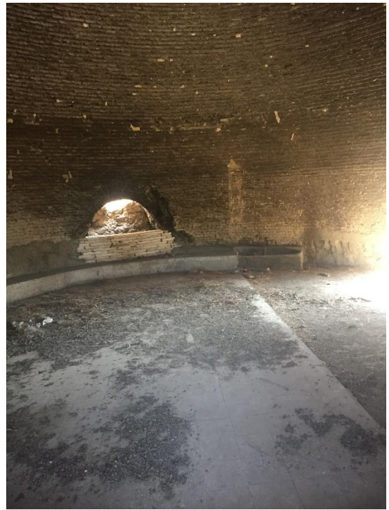
Le reservoir a été recouvert de ciment, (Anahita OyarHossein, 26.7.2018)
