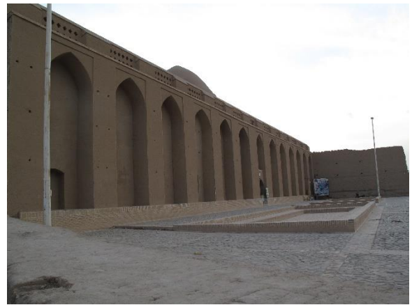
Figure 50: Murs d'ombrage après restauration, (Anahita Oyarhossein, 20,01,2019)
