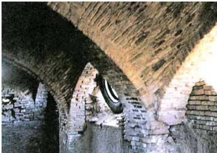
Arches de la glacière souterrain de Saveh. Les événements d'air de ce type de glacier étaient ouverts pendant les saisons froides et fermés pendant les saisons chaudes. (Ghobadian, 1998)
