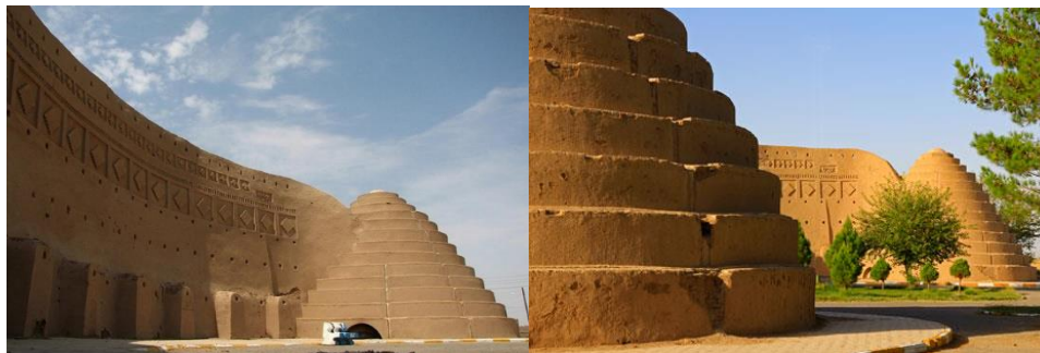
Figure 45: Murs d'ombrage incurvés des glaciers de Sirjan, (www.kojaro.com)
