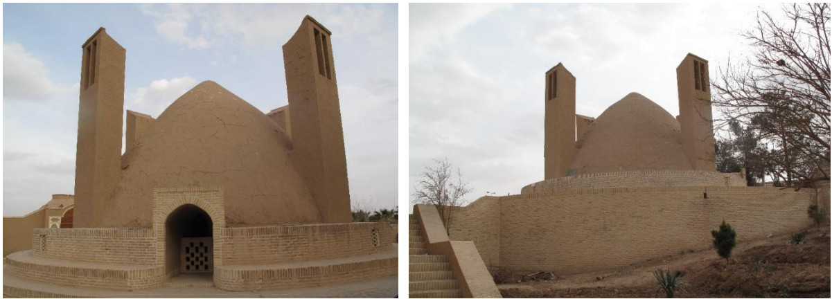
Figure 24: Le réservoir d'eau de Meybod, (Anahita Oyarhossein, 20,01,2019)
