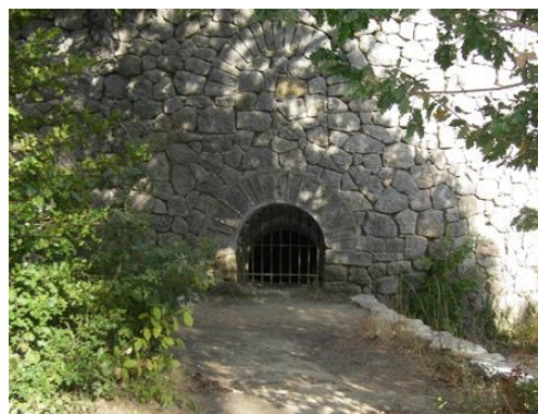
Figure 90: Extrémité de la galerie d'évacuation des eaux de fonte de la glace qui sert également de galerie d'accès pour l'entretien de la glacière lorsque celle-ci est vide -, (randojp.free.fr)
