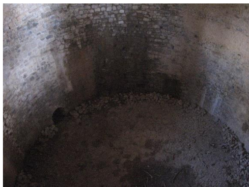
Figure 89: Le puits de la glacière avec la Sortie du canal d'évacuation des eaux de fusion au fond, (randojp.free.fr)
