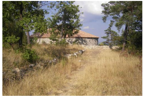
Figure 85: Bassins de congélation à la glacière de Pivaut. A gauche, un des murs de séparation des bassins. (histoire-eau-hyeres.fr)
