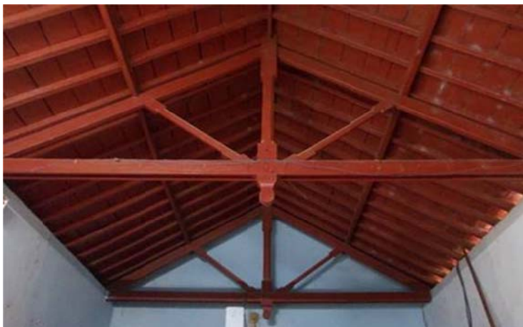
Fig. 3.40 Charpente typique des gares en série. Source: Image prise par l'auteur en 2018
