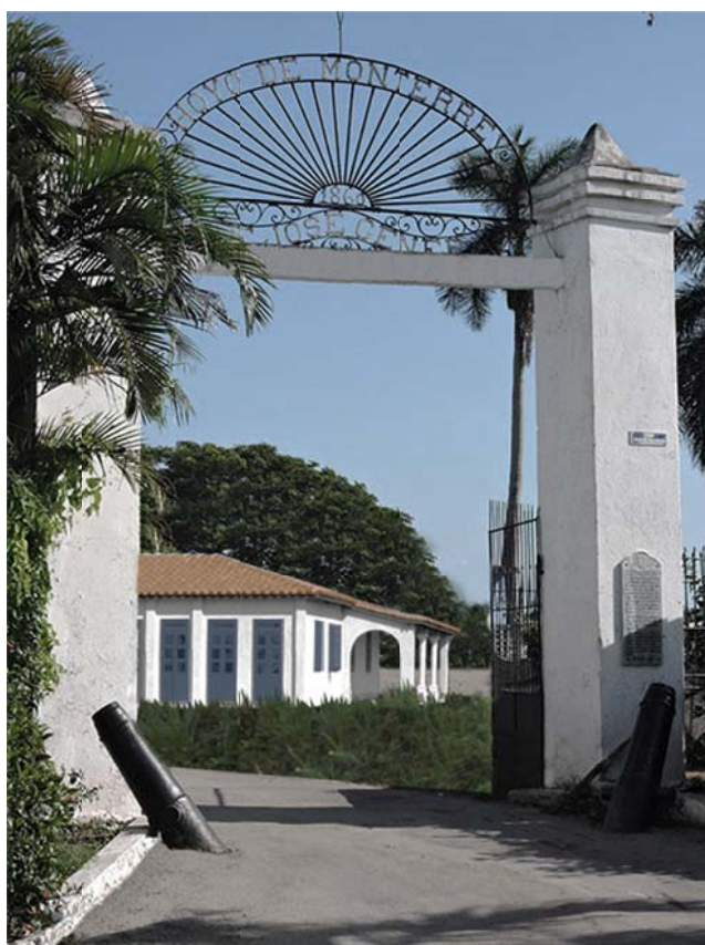
Fig. 4.48 Logement touristique Hoyo de Monterrey .
