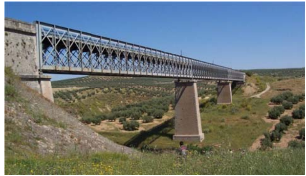
Fig. 1.13 Viaduc en structure métallique.
