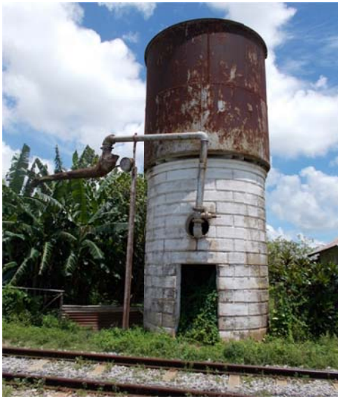
Fig. 3.50 Château d'eau qui conserve le bras mécanique.
