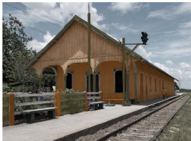
Fig. 4.44 Centre d'interprétation et de réception de visiteurs dans la gare de Puerta de Golpe.
