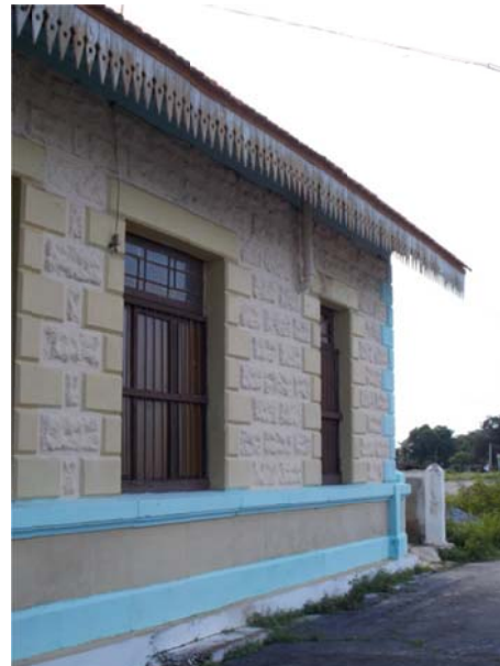
Fig. 3.41 Détail des façades des gares en série. Source: Image prise par l'auteur en 2018
