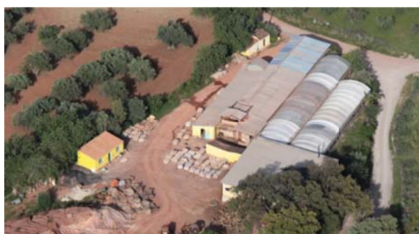
48. Vue aérienne de l'usine Terracota do Algarve .
