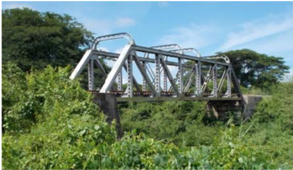
Fig. 3.48 Pont à treillis type Pratt près de Sábalo. Source: Image prise par l'auteur en 2018
