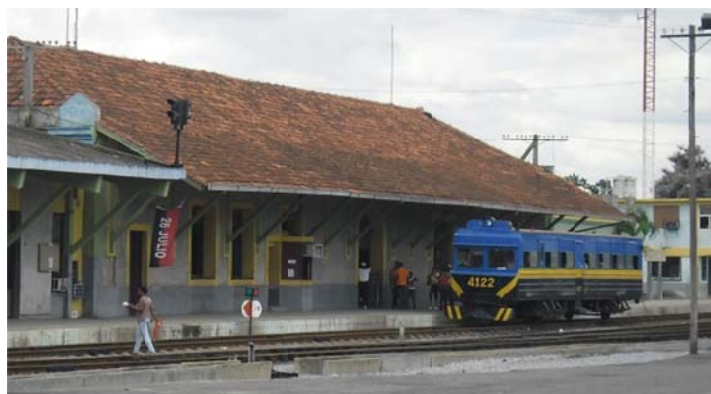
Fig. 3.30 Façade vers les voies, gare de Pinar del Río.
