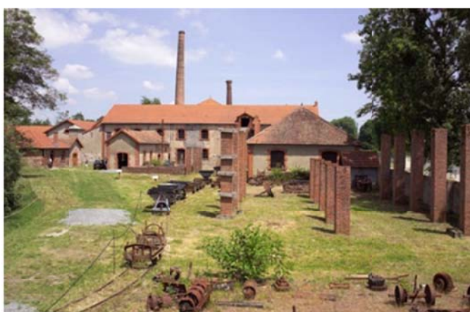
32. Briqueterie des Touillards-Vairet-Baudot , Saône-et-Loire, Bourgogne. Actuellement transformée dans un écomusée. Source: http://www.ecomusee-creusot-montceau.fr/spip.php?rubrique62
