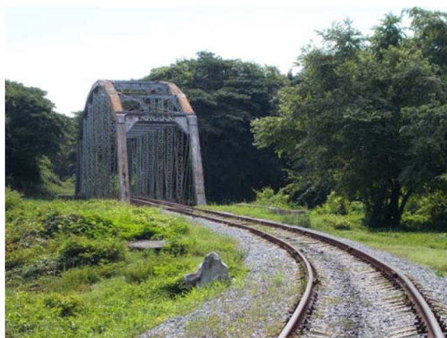
Fig. 3.46 Pont à treillis type Parker sur la rivière Cuyaguaje. Source: Image prise par l'auteur en 2018
