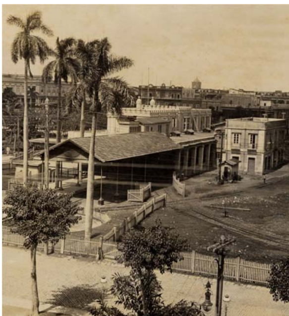
Fig. 3.4 Gare de Villanueva, démolie en 1912, La Havane.
