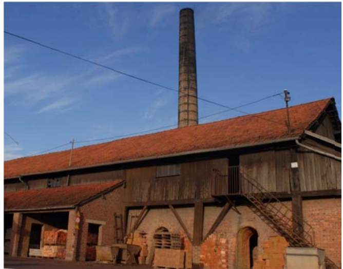
30. Briqueterie Denulf, Picardie, France.
