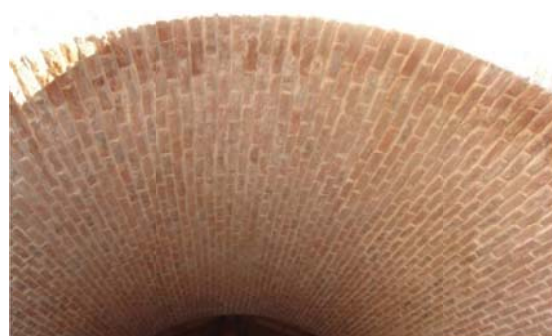
49. Arch Aboboda construite avec des briques tijolos burros produites dans l'usine Terracota do Algarve .
