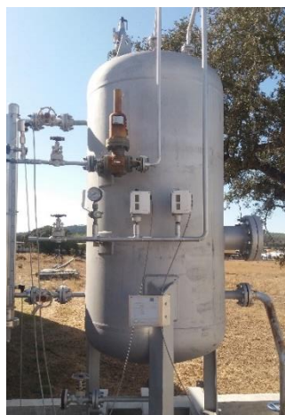
Figura 11 - Vaso de expansão
