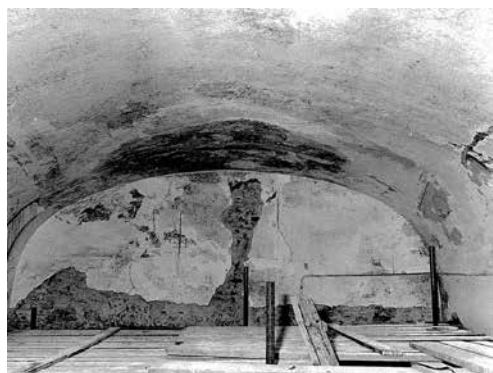
Fig. 19. Palma, troço da abóbada do espaço de saúde onde, sob a camada de cal, existiram frescos com a temática do Capítulo IX, do Evangelho de S. Mateus, 1987, Évora. Fonte: CME.
