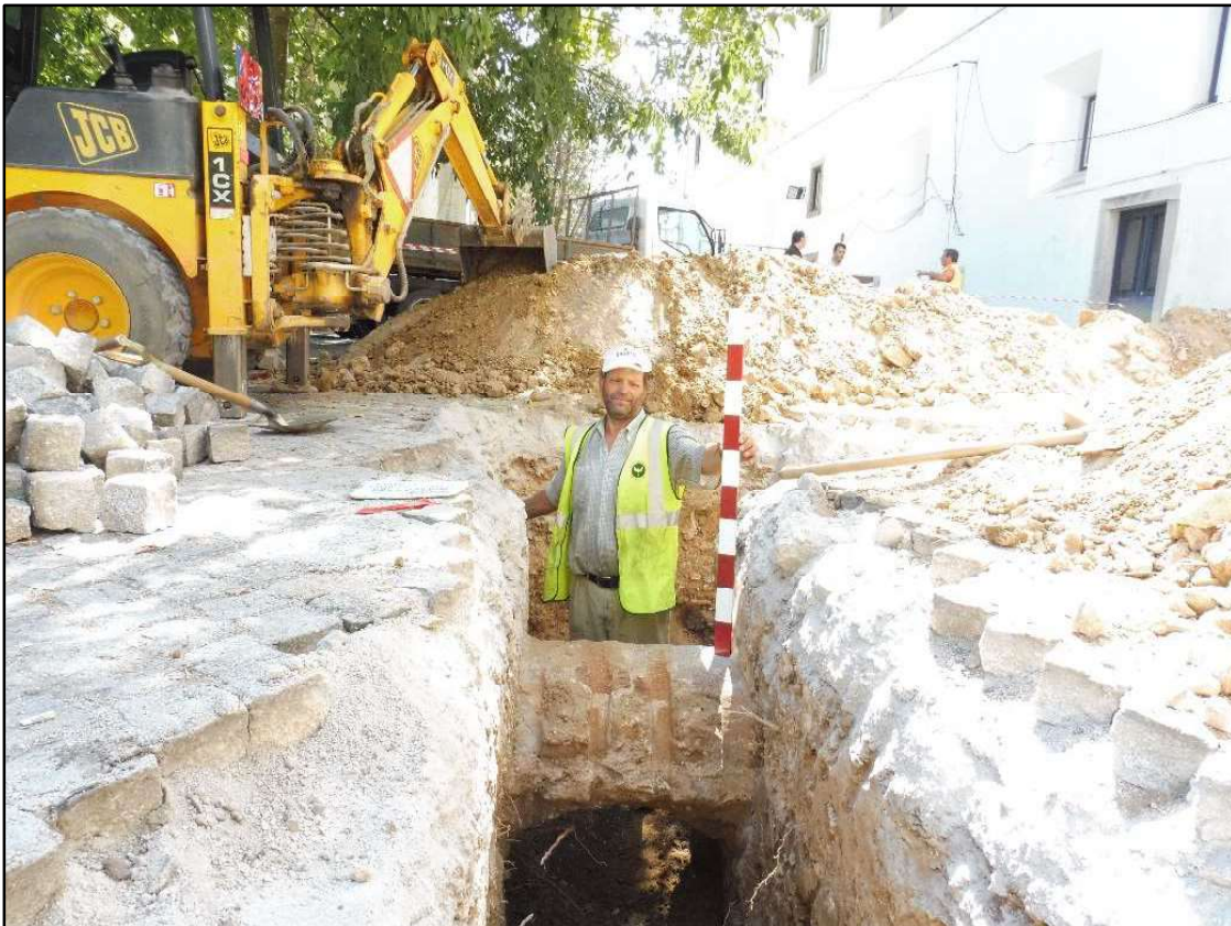
Figura 19. Pormenor de uma das tubagens de esgoto identificadas (sgd. Oliveira e Rocha, 2016).
