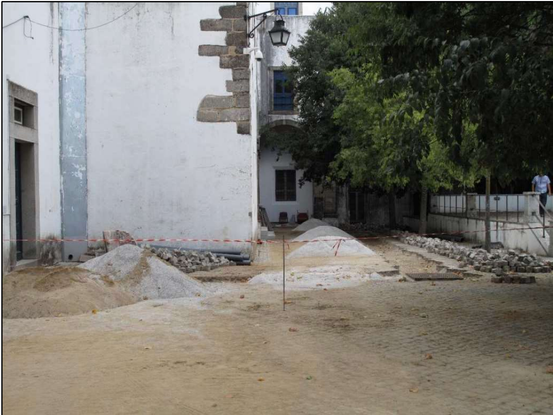
Figura 20. Vista geral final da obra (sgd. Oliveira e Rocha, 2016).
