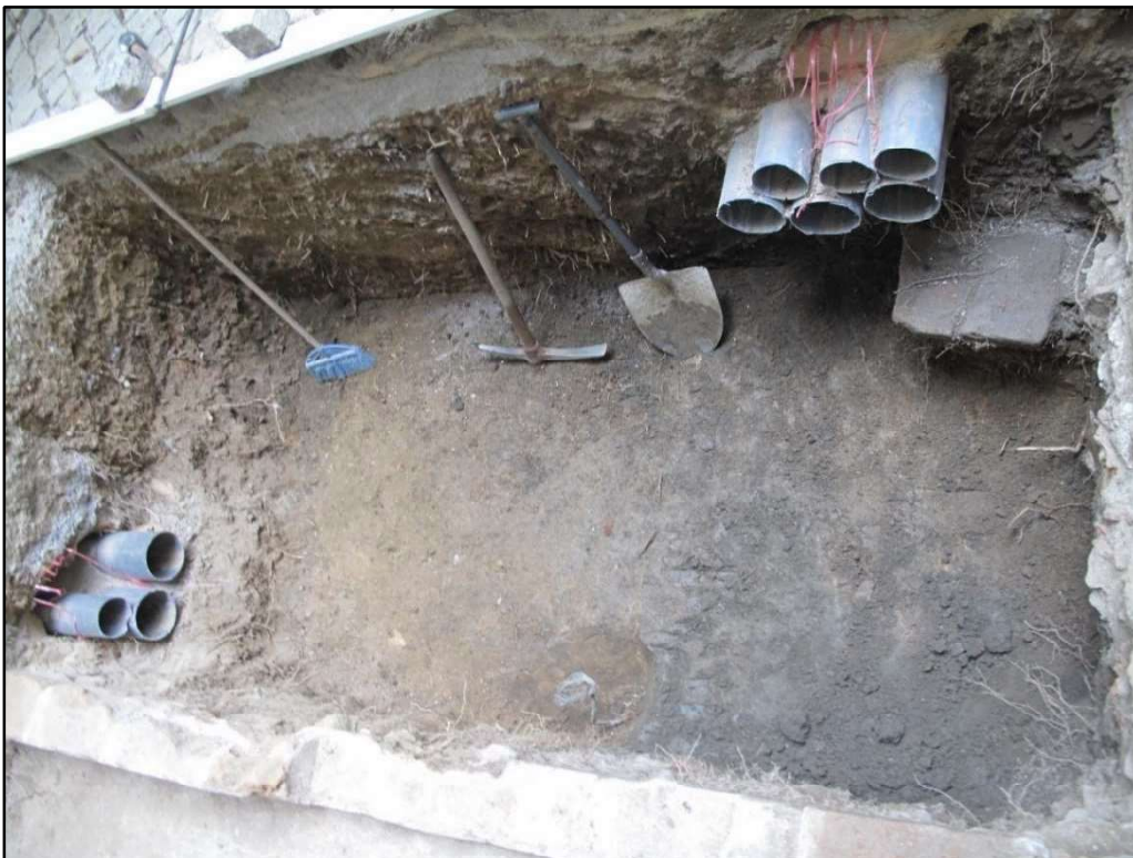
Figura 24. Aspeto final do poço, com visualização das infraestruturas anteriores, cortadas (©Leonor Rocha).
