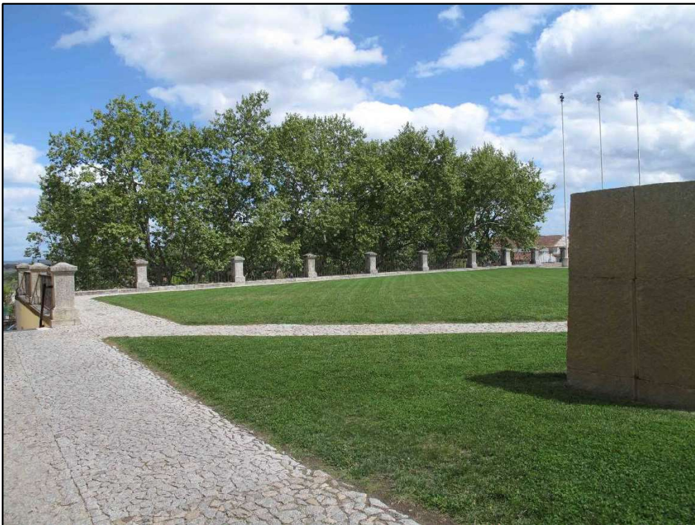
Figura 14. Aspeto atual da cobertura do Restaurante Cozinha do Cardeal. (©Leonor Rocha)
