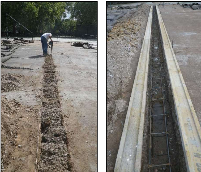
Figura 16. Aspeto dos trabalhos realizados nos campos, na 1ª Fase (©Leonor Rocha).
