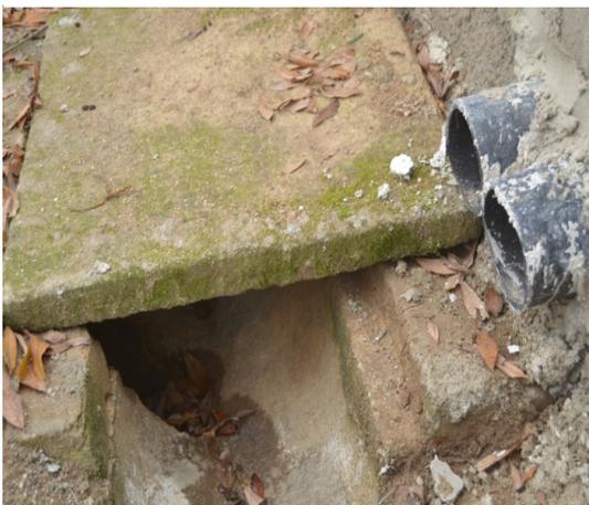
Figura 15 - Pormenor de sistema de drenagem de água com acumulação de água (original do autor)
