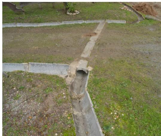
Figura 16 - Sistema de drenagem de água com possibilidade de acumulação (original do autor)
