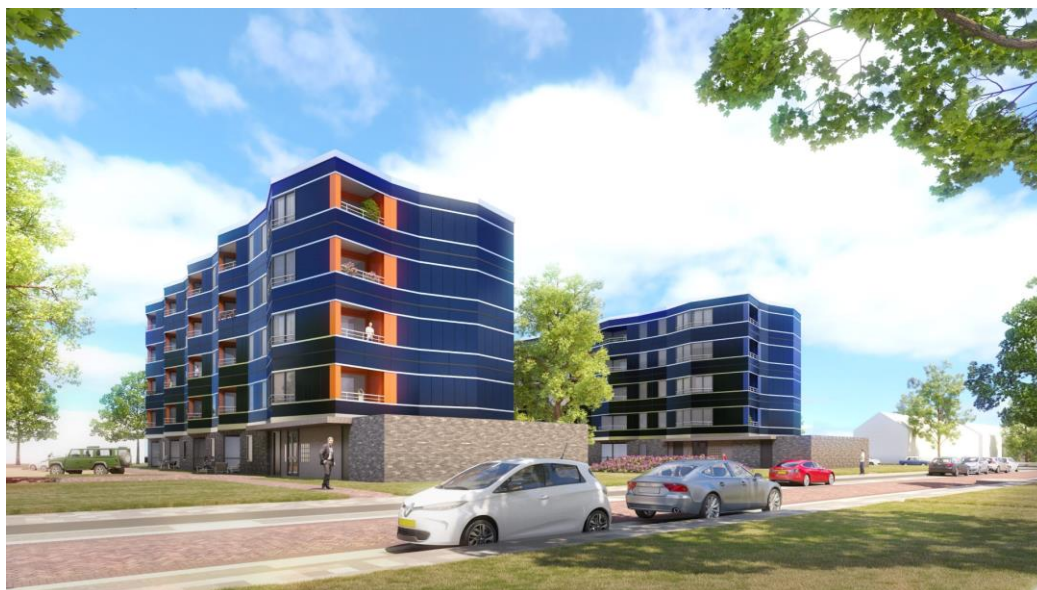
Figura 3. Edifício em Holanda, totalmente revestido por módulo PV [13]
