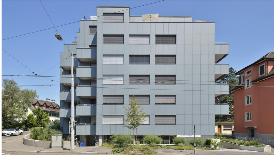
Figura 1. Edifício em Zurique de caráter residencial revestida de módulos PV [13]
