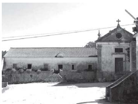
Fig. 9 – Quinta de Vale de Ventos – Vista da capela e do edifício de habitação.
