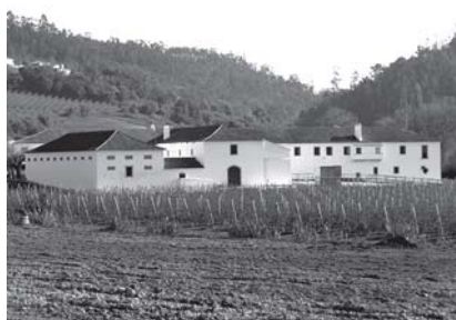
Fig. 13 – Quinta do Vimeiro. Vista atual do conjunto da antiga granja.
