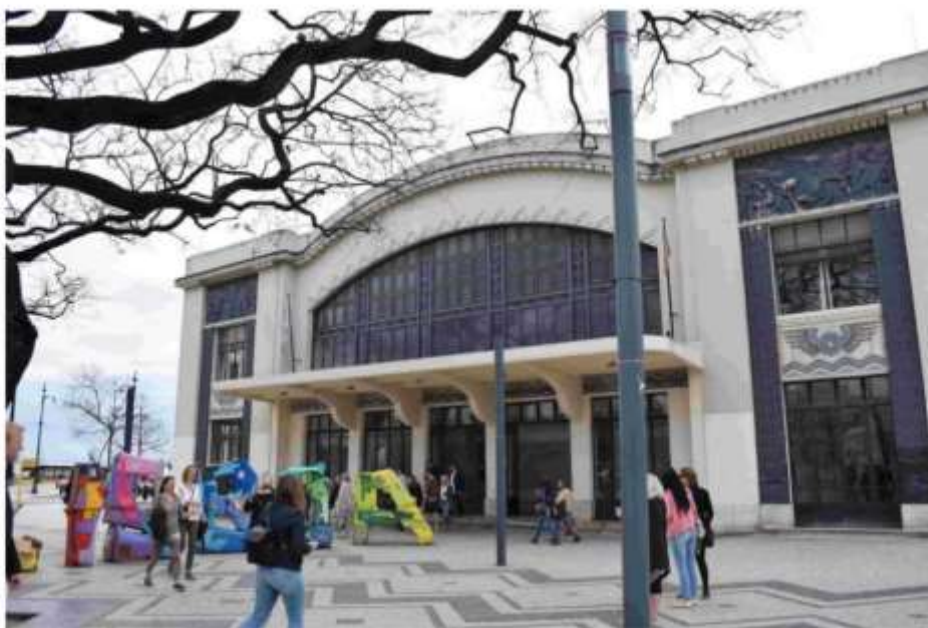
Figura 4. Fachada Principal da Estação do Cais do Sodré
