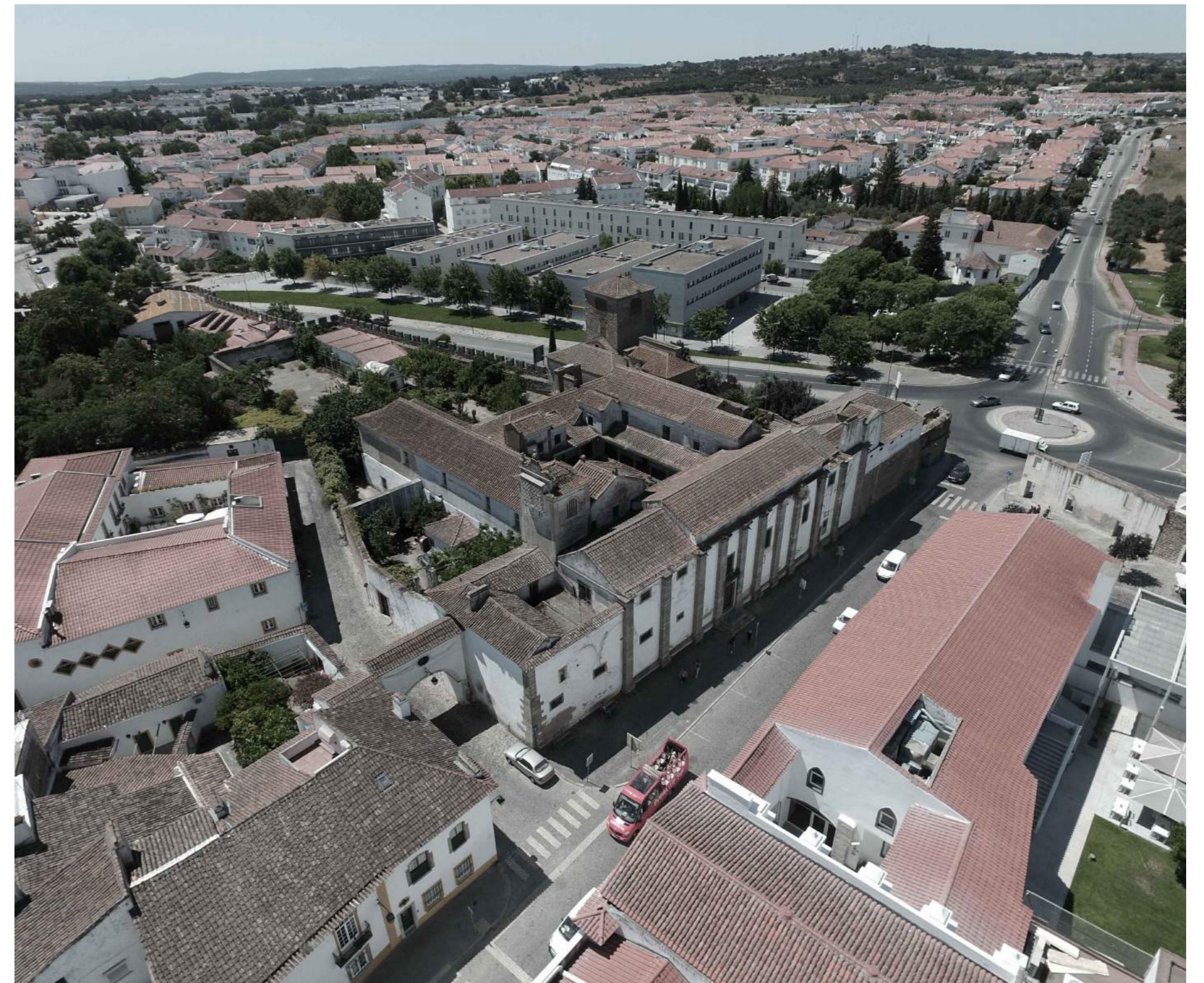
87 Vista aérea do mosteiro de Santa Helena do Monte Calvário
