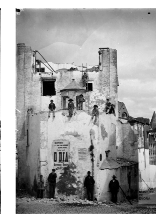
69 Demolição do mosteiro
