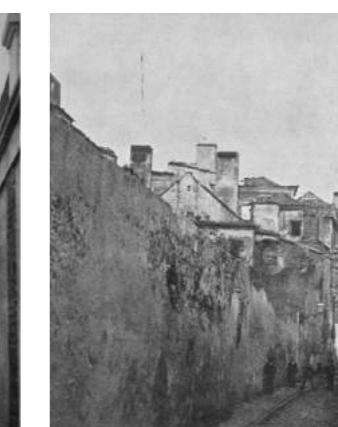
64 Demolição do mosteiro
