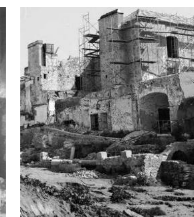
29 Edifício antes de intervenção
