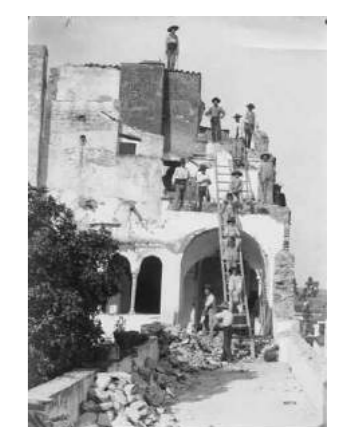
71 Demolição do claustro
