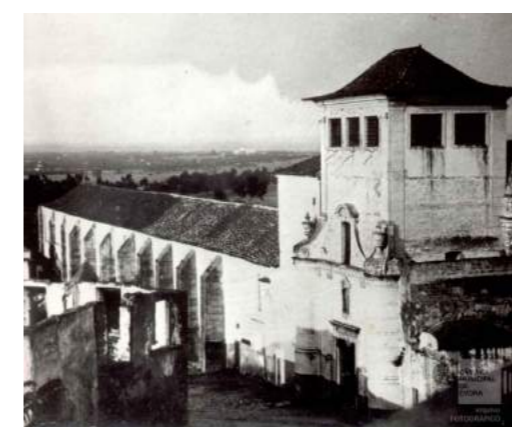
41 Conjunto monástico antes da demolição
