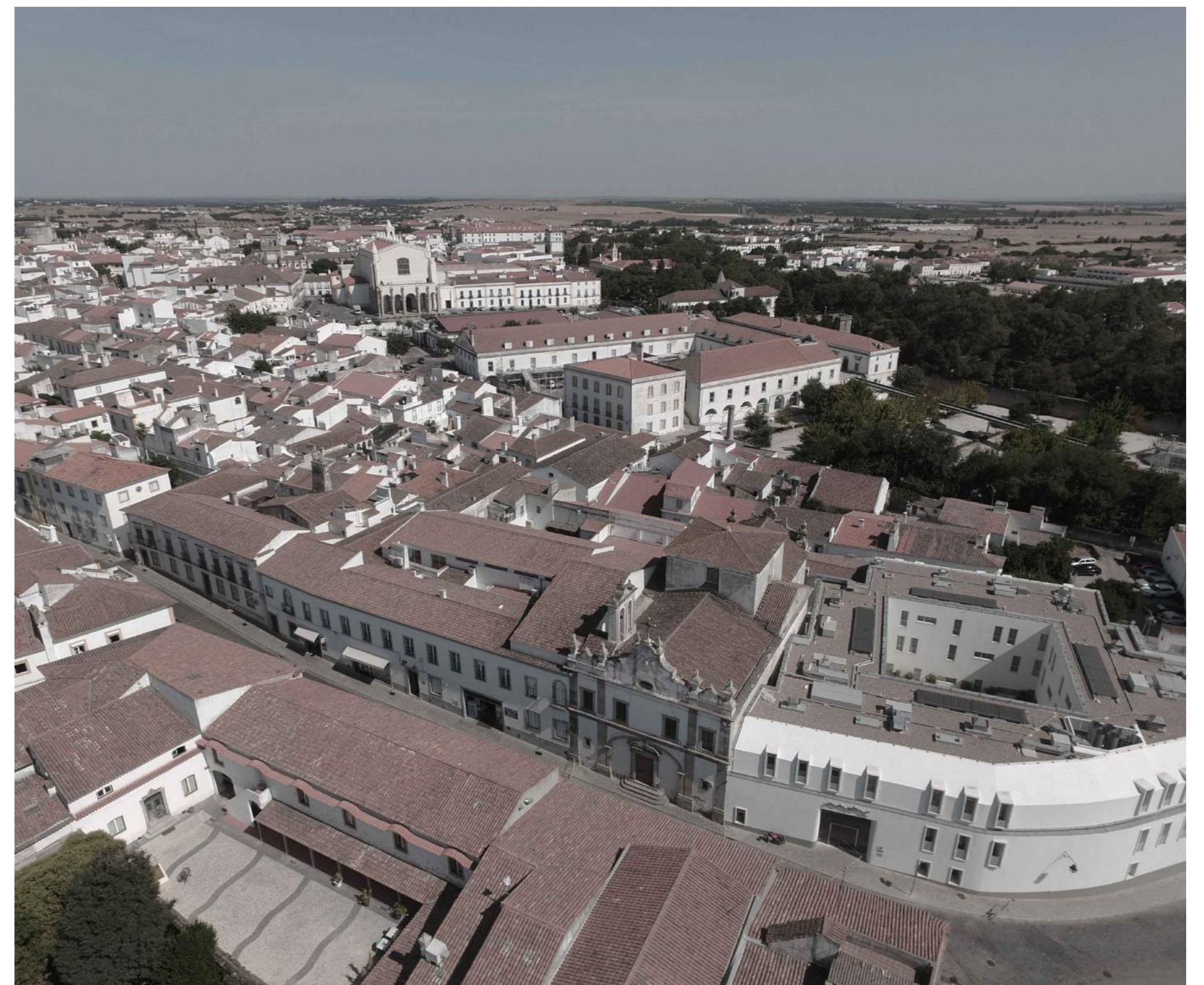
108 Vista aérea do mosteiro de Nossa Senhora das Mercês
