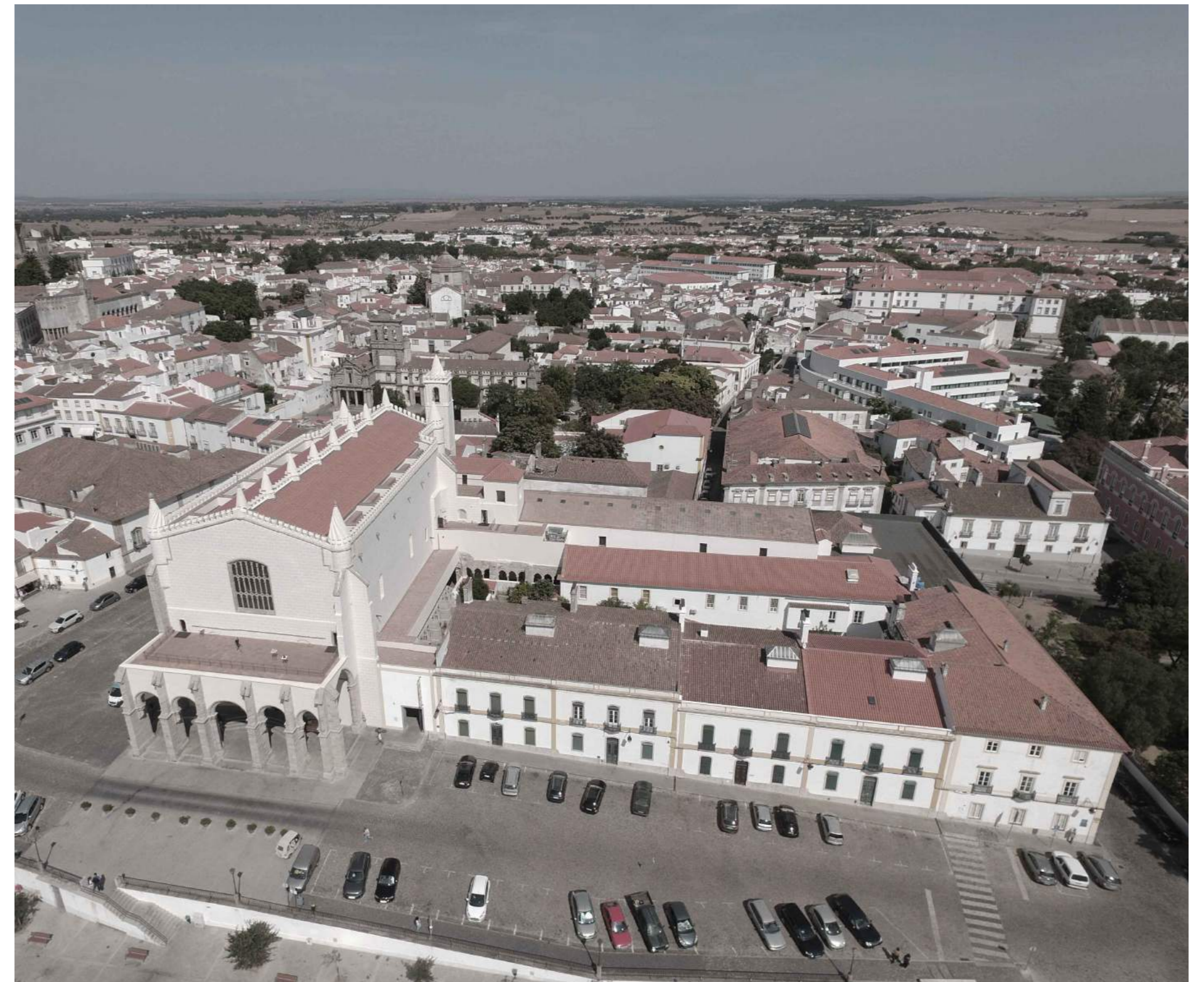
14 Vista aérea do mosteiro de São Francisco
