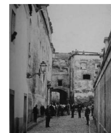
63 Demolição do mosteiro
