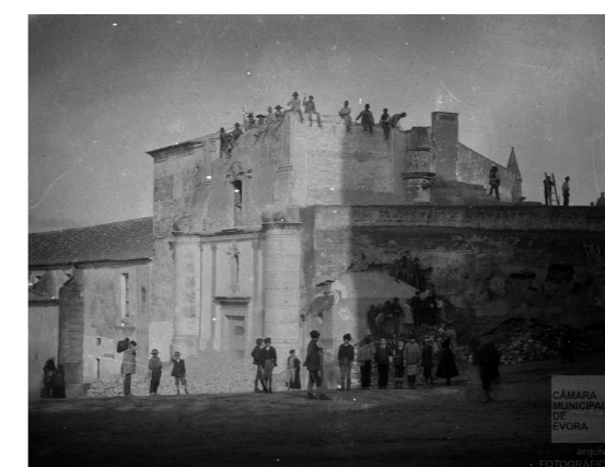
42 Demolição da igreja
