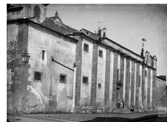
88 Fachada do Convento do Calvário
