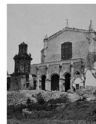
15 Fachada poente da igreja, troço do aqueduto e da caixa demolidos
