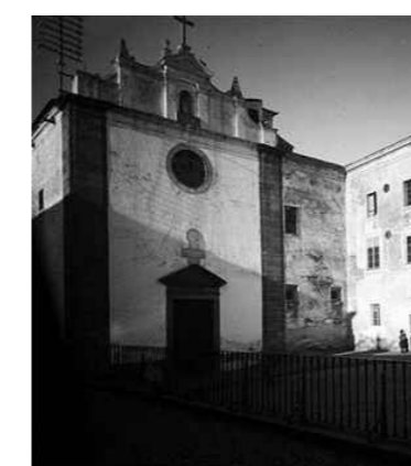
98 Frontaria antes da demolição
