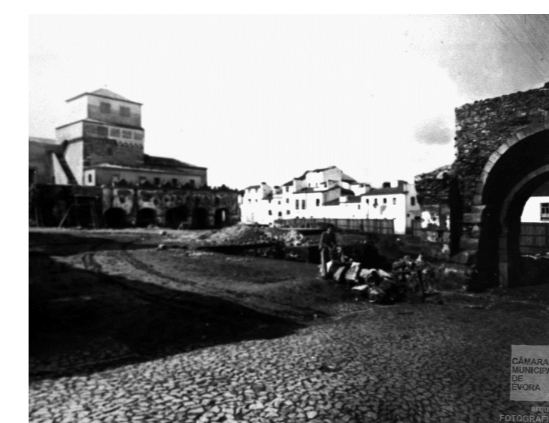
99 Demolição de parte do conjunto
