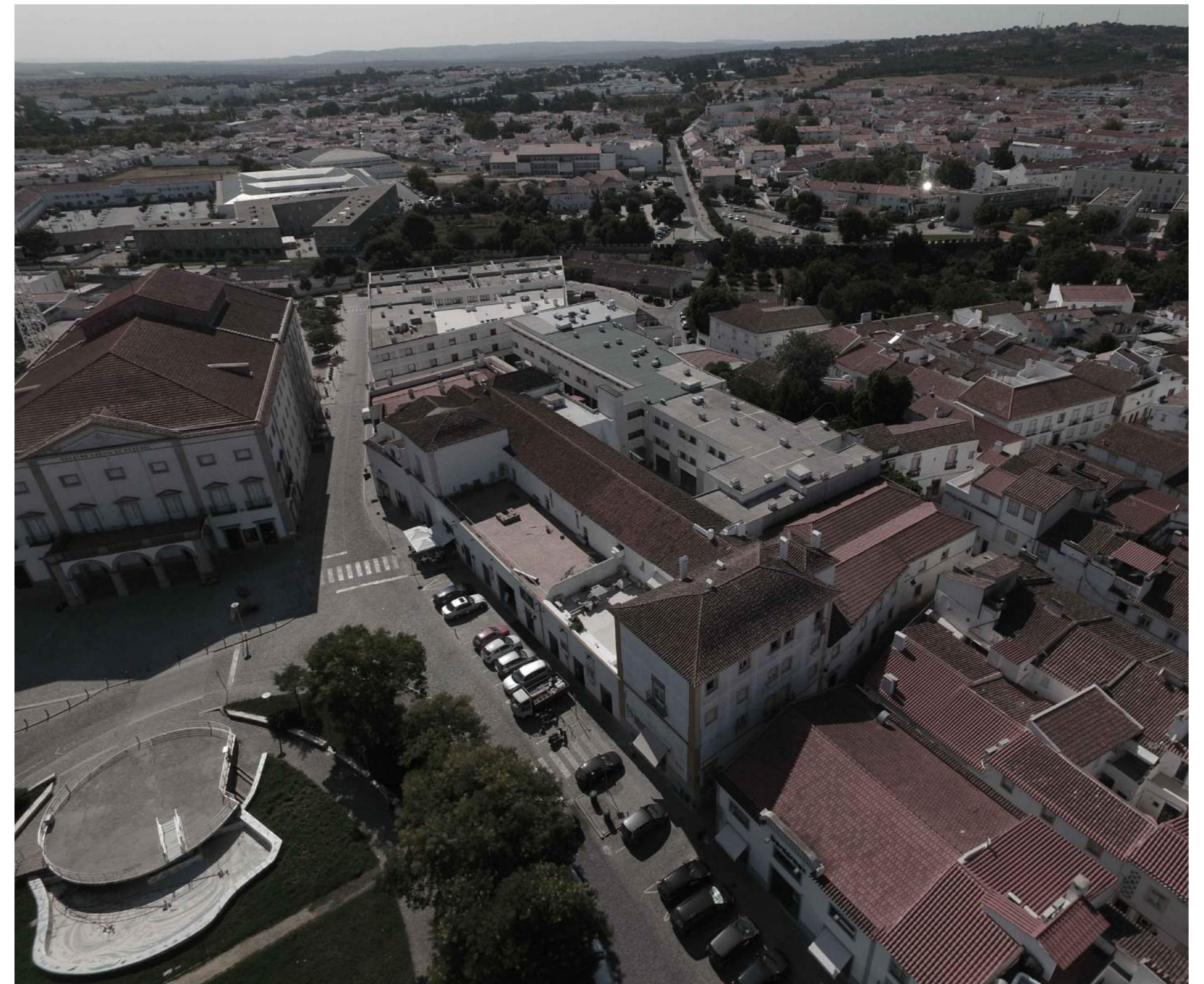
25 Vista aérea da área anteriormente ocupada pelo mosteiro de São Domingos
