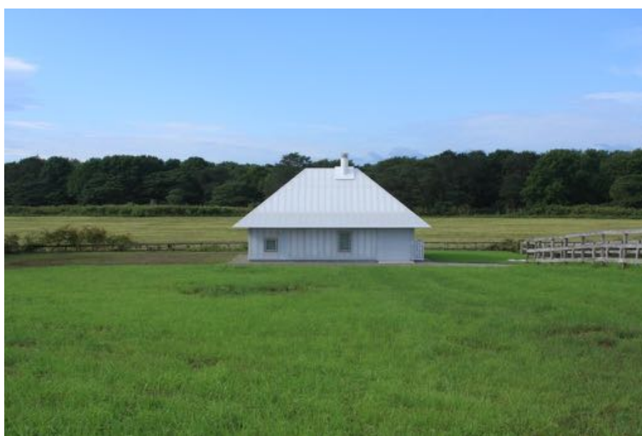
Figura 76 - Vista exterior da Casa Meme na Primavera;
