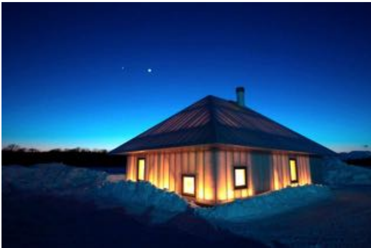
Figura 77 - Vista exterior da Casa Meme;
