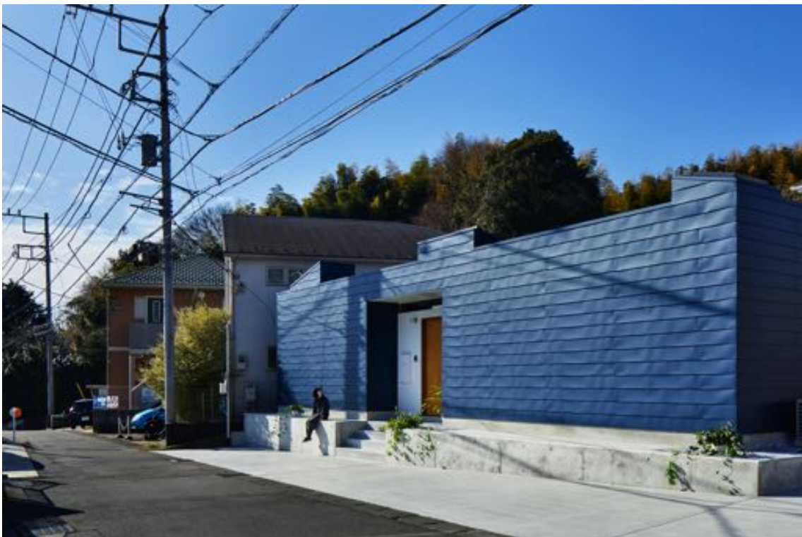
Figura 116 e 117 - Vistas exteriores da casa
