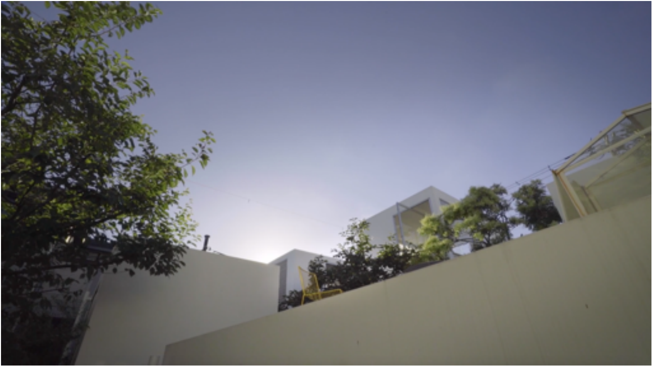
Figura 48 - Vista do Pátio da Casa Moriyama;
