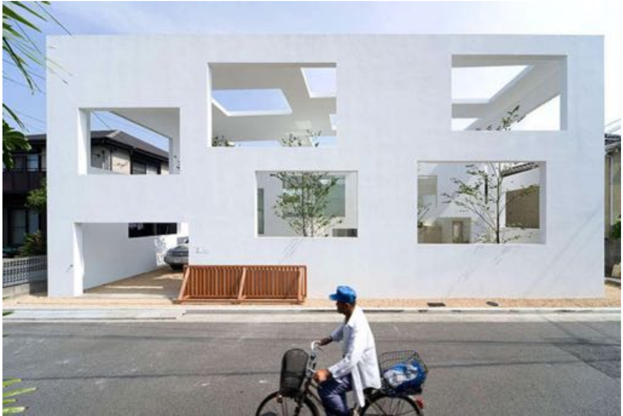
Figura 64 - Vista exterior da Casa N;
