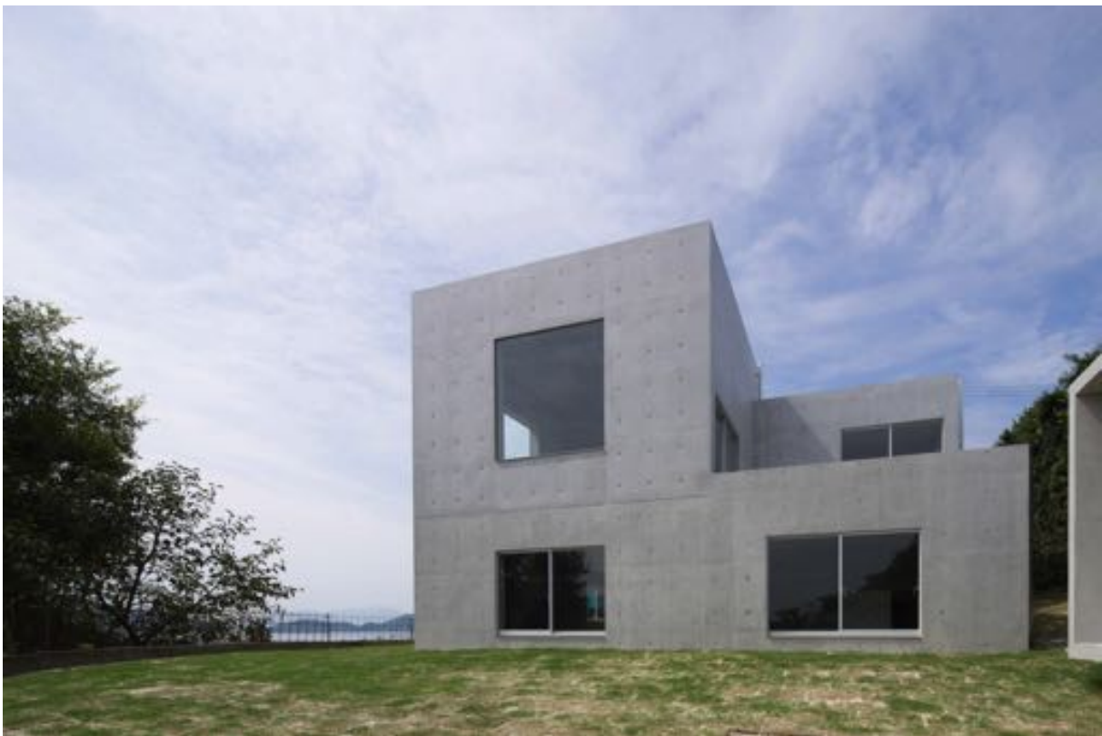
Figura 103 e 104 - Vistas exteriores da casa;
