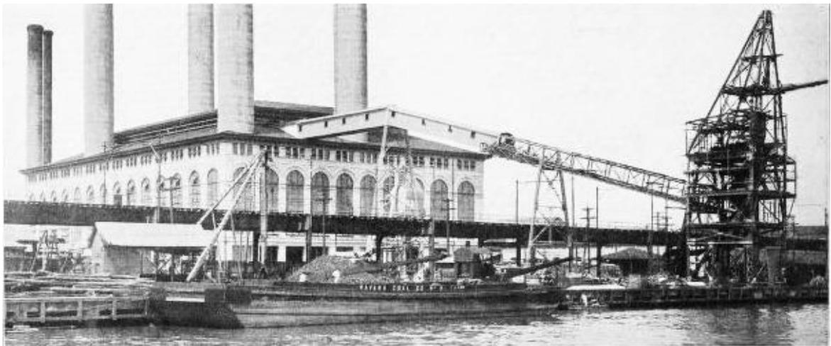
Fig.59. Vue du bâtiment dès la baie. Grue pour transporter le charbon et chemin de fer élevé de l' Station centrale de La Havane 1914. Source : (Steinhart, 1914)
