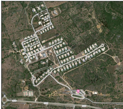
Localização do espaço de intervenção - Alma Verde Resort
