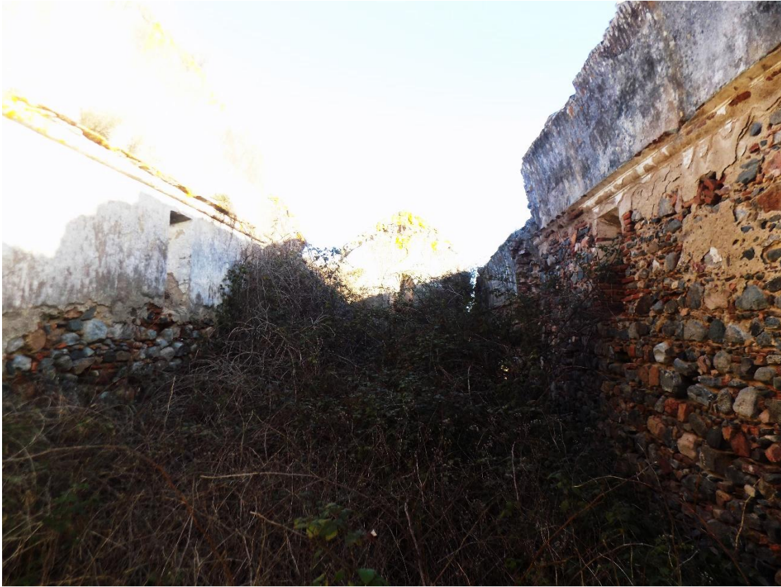
Figura 59 Estado atual do interior da Ermida de São Fausto.
