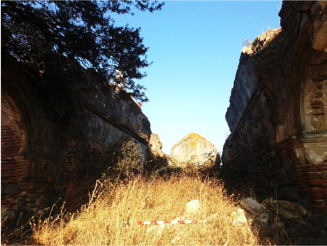
Figura 61 Ermida de São Fausto, vista interior.
