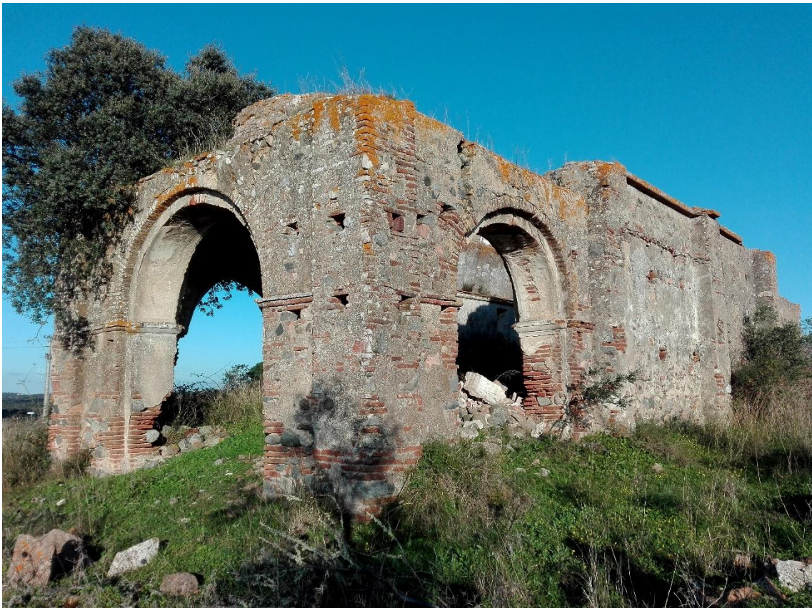
Figura 56 Ermita de São Fausto - vista lateral.
