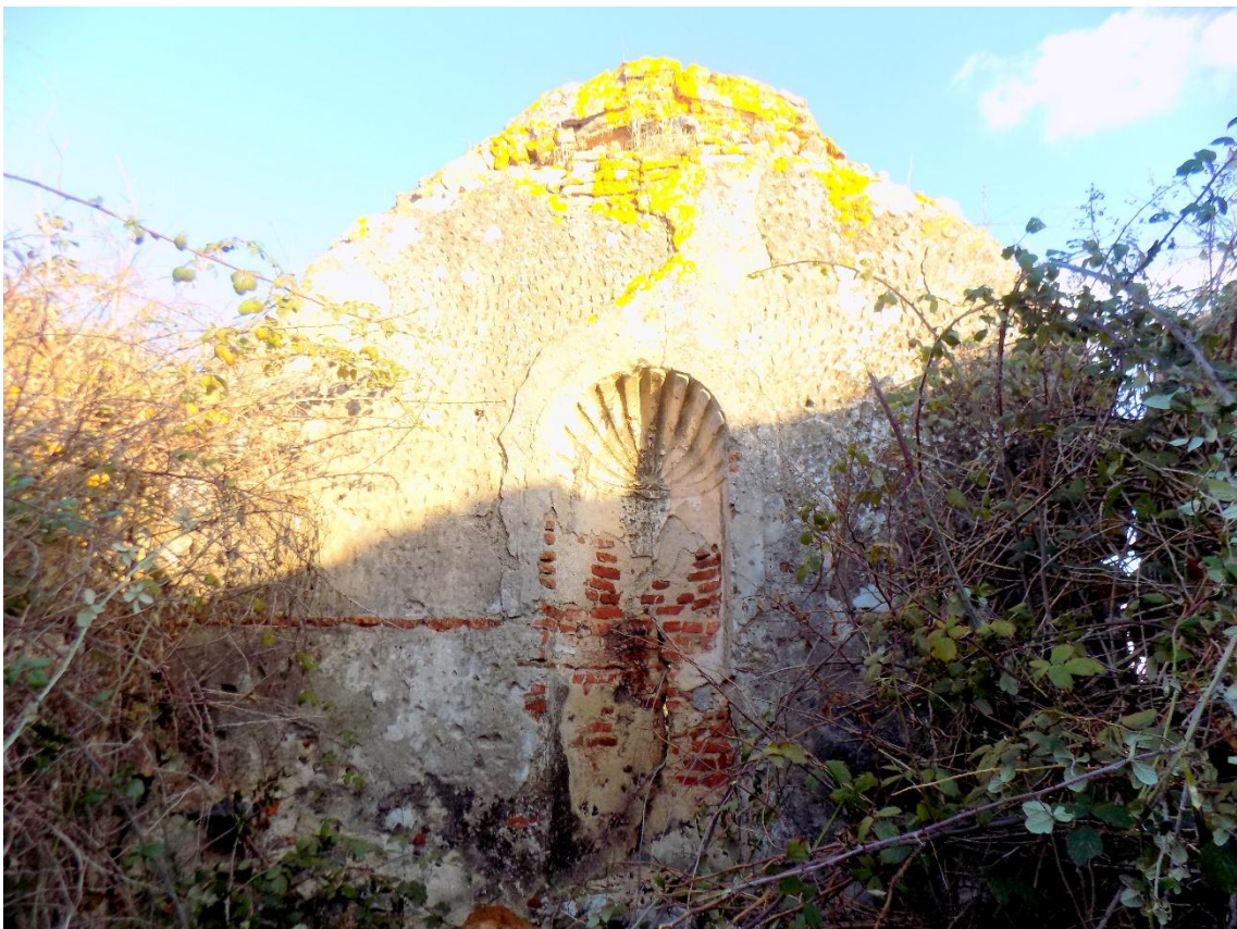
Figura 60 Pormenor do oratório no interior da Ermida de São Fausto.
