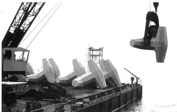
Fig. 71. Barcaça de colocação dos dolos no extra-dorso de Molhe Oeste. sd.
