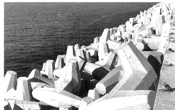
Fig. 72. Molhe Oeste com proteção de dolos. 1976.
