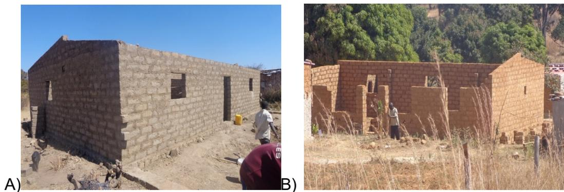
**Figura 2.20** – Tipologia de habitação amplamente praticada atualmente na Província da Huíla. A) Construção de casa de adobe no município da Chibia; B) Construção de casa de adobe no município de Kaluquembe. Fonte: Fotografia de Wachilala.
