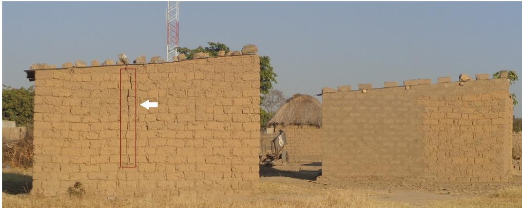
**Figura 2.22** - Ilustração de algumas patologias estruturais nas habitações: degradação por fissuração, na Província da Huíla. Fonte: Fotografia de Wachilala.
