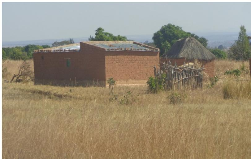
**Figura 2.21** – Casas de adobe sem reboco exterior, comuna da Negola, Kaluquembe. Fonte: Fotografia de Wachilala.
