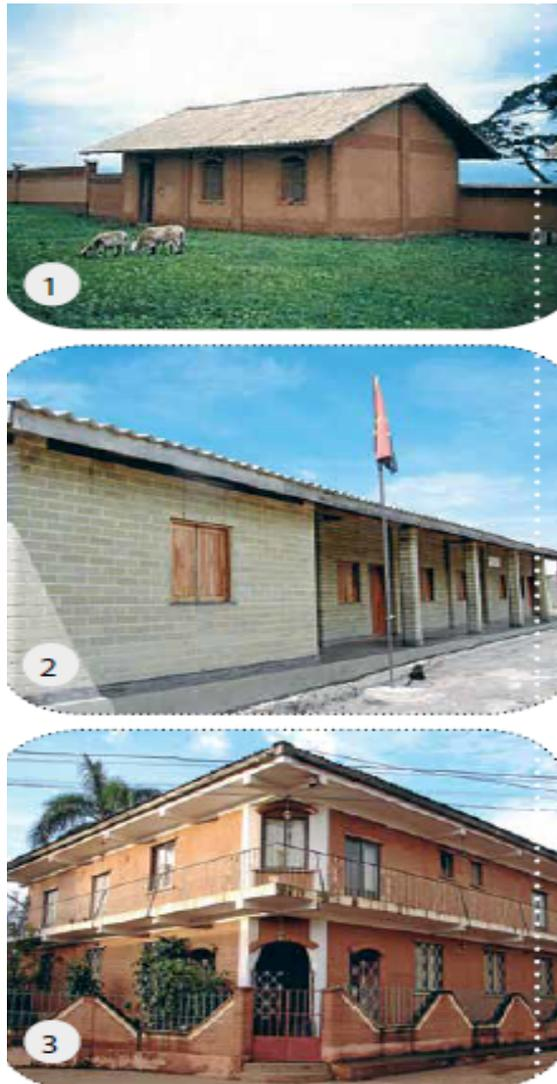
**Figura 2.28** – Infraestruturas construídas com recurso a BTC, Kuanza Sul, Região Centro Litoral de Angola. Fonte: Ganduglia (2012).
