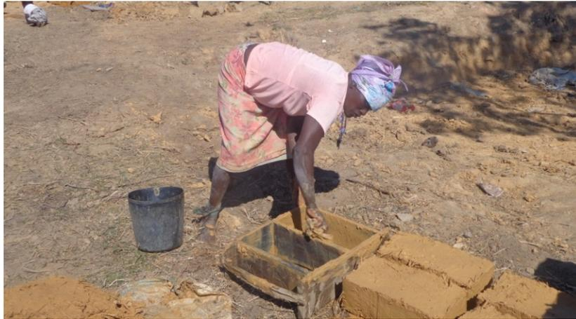
**Figura 2.23** – Moldagem manual dos blocos de adobes. Fonte: Fotografia de Wachilala.
