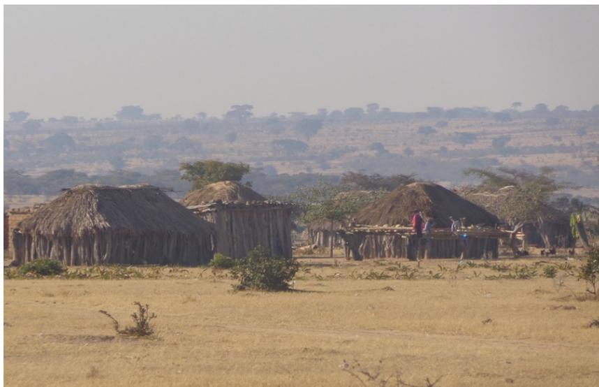
**Figura 2.26** – Casas de pau-a-pique, técnica amplamente utilizada na construção tradicional da Região Sul de Angola. Fonte: Fotografia de Wachilala.
