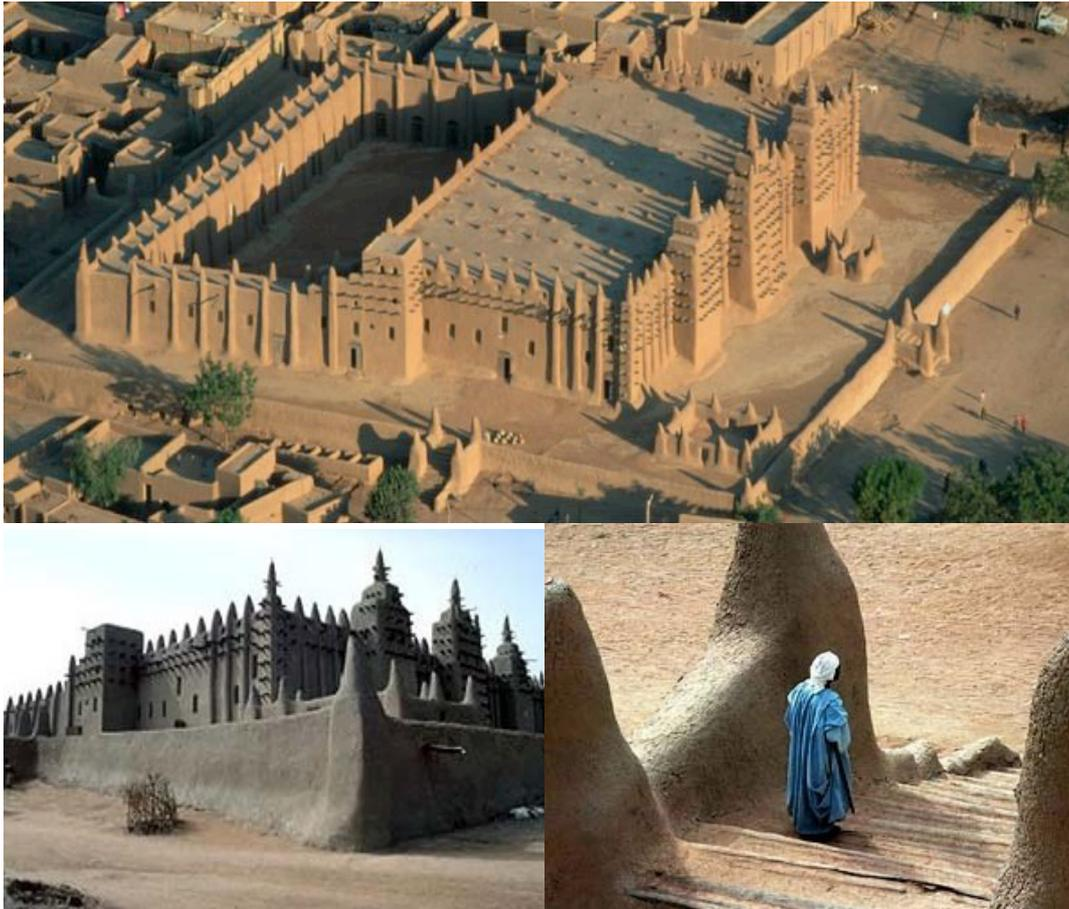
**Figura 2.12** – A Grande Mesquita de Djenné, atualmente a maior obra em terra crua, construída em adobe, Mali (1280 d.C.) (África Ocidental). Fonte: Jahn (2005); Williams e Kniveton (2011).
