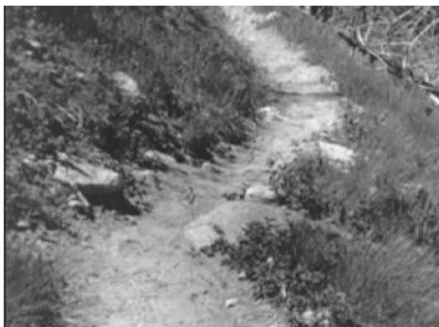
Figura 22: Colocação de pedras para delinear o caminho
