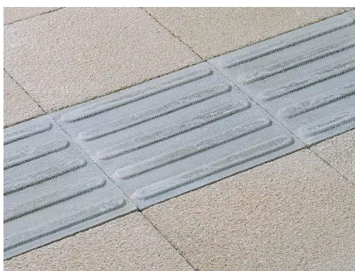
Figura 46 Pavimento Guia com Riscas
