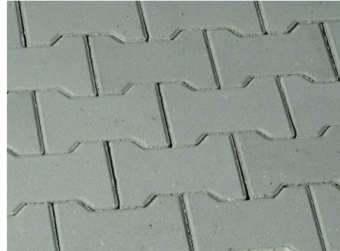
Figura 45 Pavimento em Pavé I
