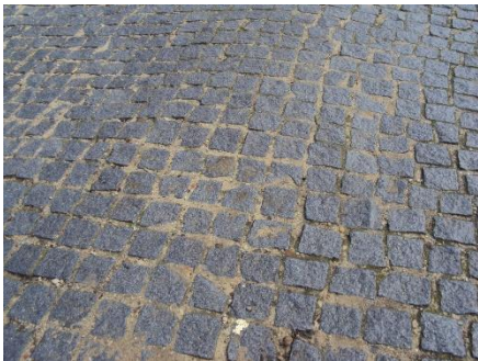
Figura 23 Pavimento em Calçada Grossa de Granito
