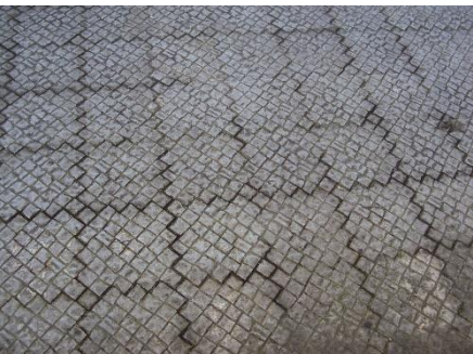
Figura 25 Pavimento em Calçada 2000
