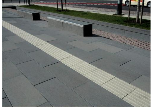
Figura 7 Pavimento Táctil Guia
