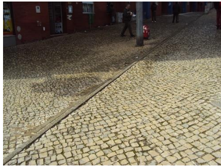
Figura 24 Pavimento em Calçada Miúda de Calcário
