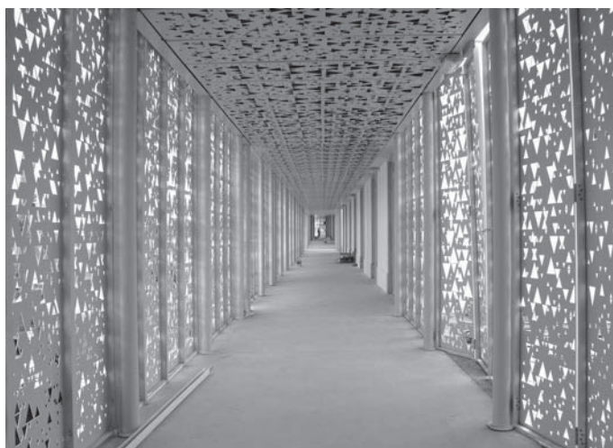
Fig. 3. Vista parcial do corredor de ligação, em fase de obra.
