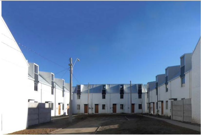
Ilustração 15..... Vista original exterior: Barnechea, Santiago (fot. Elemental)
