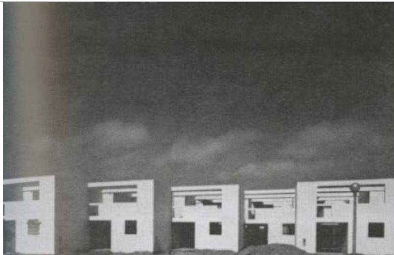
Ilustração 18. ..... Vista original exterior: PREVI. Lima (fot. Correa, C: Housing & Urbanization.)
