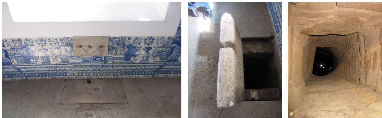
Figs. 29, 30 e 31 – Vistas do acesso à cisterna e do seu interior. Fonte: acervo pessoal.
