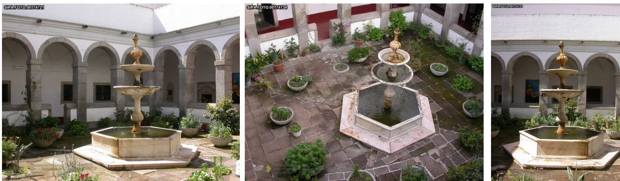
Figs. 34, 35 e 36 – Algumas vistas antigas do claustro do convento, quando este ainda se encontrava em funções.
