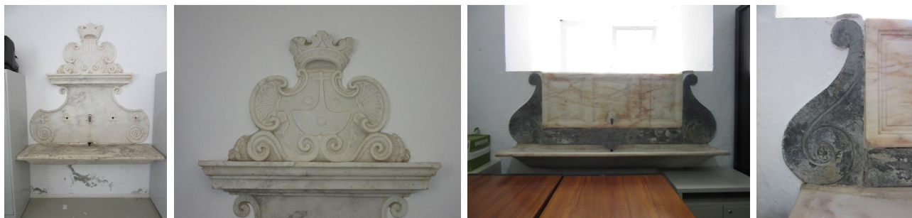
Figs. 17, 18, 19 e 20 – Vistas do lavabo situado no antigo refeitório e de um lavabo que se encontra num espaço anexo à sacristia.
