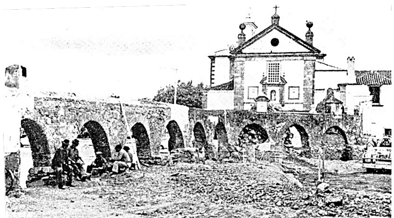
Fig. 18 – Vista de inícios do século XX, em que é nítida a arcaria de abastecimento ao convento.
