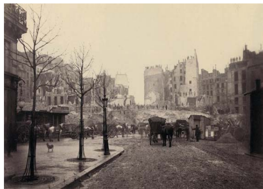
fig. 019 Construction of the avenue de l'Opéra Butte des Moulins, Charles Marville, 1876.
