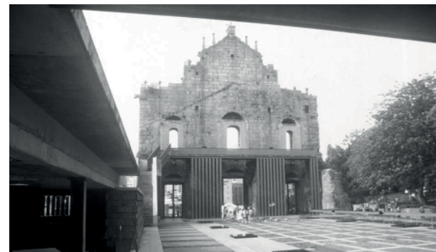
fig. 070 Vista Interior, Recuperação e Conversão das Ruínas de São Paulo em Museu, Macau, João Luís Carrilho da Graça, 1995.
