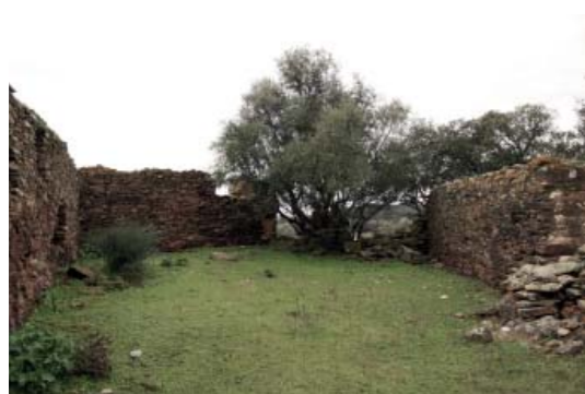
fig. 207 Pátio gerado por 3 volumes em ruína.
