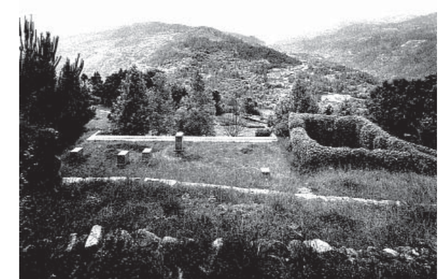
fig. 131 Vista da cobertura ajardinada, Casa em Baião, Baião, Portugal, Eduardo Souto de Moura, 1993.
