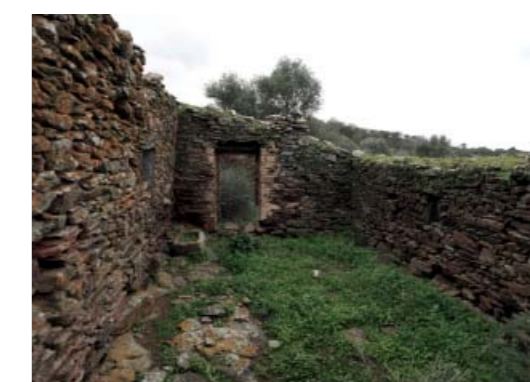
fig. 210 Ruína de um anexo agrícola e muro.
