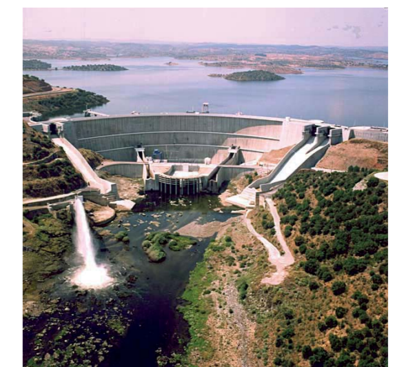
fig. 184 Barragem de Alqueva
