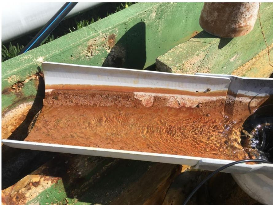
**Figura 32 – Acumulação de ferro na tubagem de saída de um tanque [fotografia original]**
