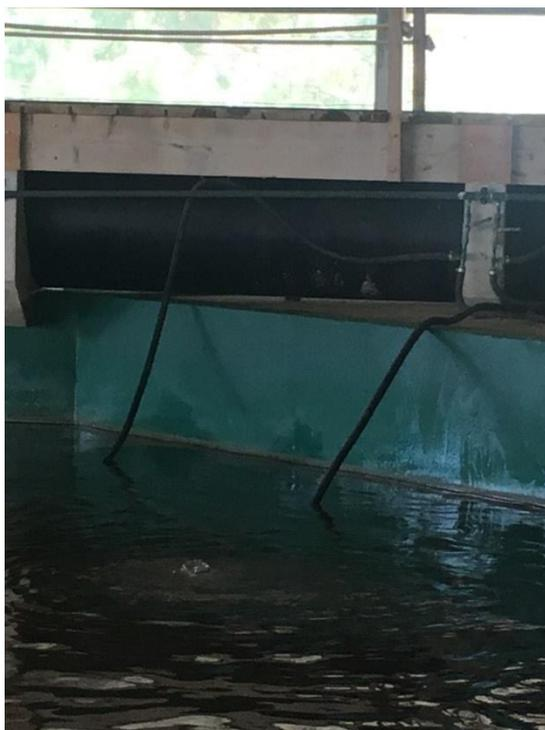
**Figura 33 – Oxigenação de emergência em funcionamento num tanque [fotografia original]**
