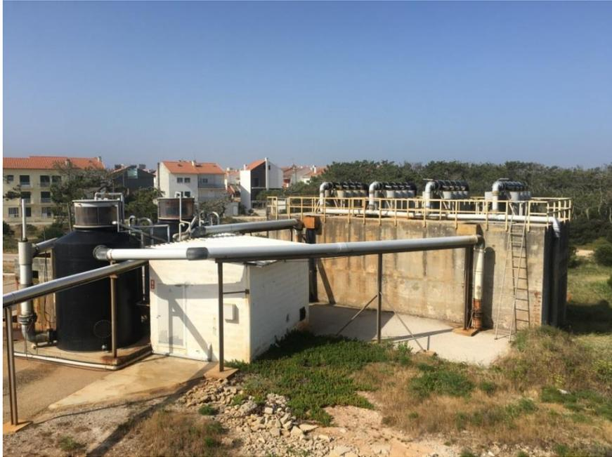
**Figura 26 – Tanque cabeceira da Fase Nova (à direita) e tanques de ozonização (à esquerda, de coloração preta) [fotografia original]**
