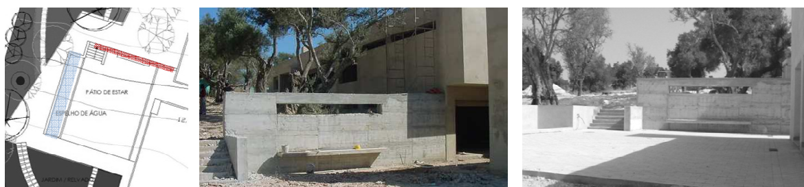
Fig. 3.43 – Da esquerda para a direita: planta do “pátio exterior (s/esc.)”; foto do início da obra em 2003 e no mesmo local, ainda em obra, em 2004. (Fotos: A.S).
