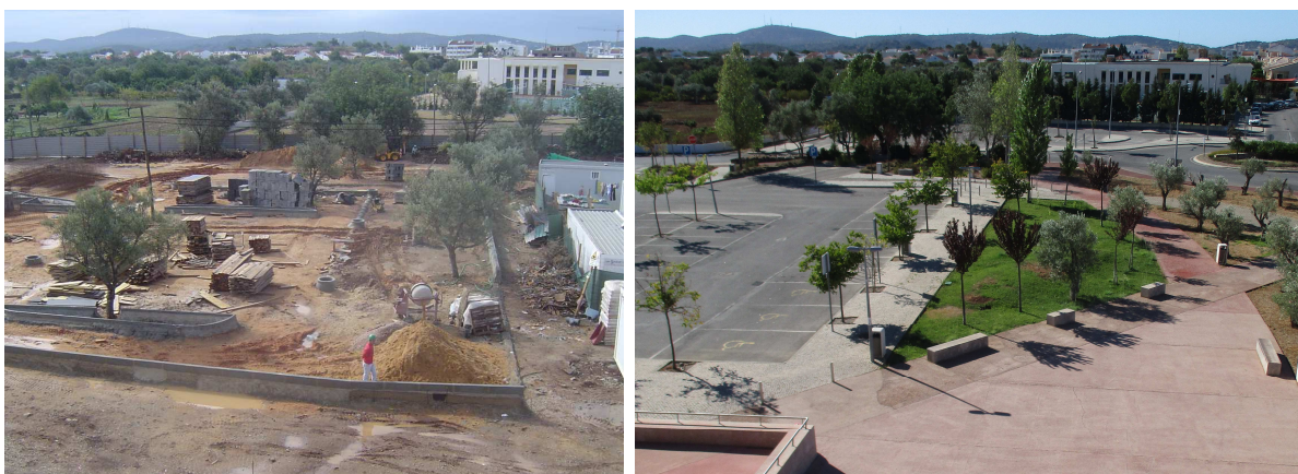
Fig. 3.33 – À esquerda: vista para sul a partir do edifício - decurso da obra, início da fase das pavimentações com colocação de guias e lancis; à direita: vista do mesmo local, na actualidade. São visíveis as alterações ao nível das relações espaciais e funcionais (sistema de circulação e de mobilidade, sistemas de vegetação, volumetrias, imagem) que caracterizaram o processo de transformação da paisagem (Fotos: Filipe Sobral).
