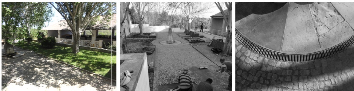
Fig. 3.63 - Aspecto pré-obra: calçada miúda existente deformada pelas raízes dos choupos e frequentemente encharcadas, levantamento e trabalhos de reposição da calçada existente e grelha de sumidouro circular proposta e assente. (Fotos: A.S).
