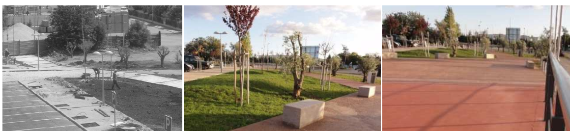
Fig. 3.32 – Da esquerda para a direita: área sudoeste - estacionamento, fase de espalhamento de terras vivas e plantações; final da obra - pavimento em betão colorido executado, bancos maciços de brecha colocados, plantações e sementeiras terminadas; vista a partir da entrada das piscinas: corrimão e guarda-corpos. (Fotos: A.S).
