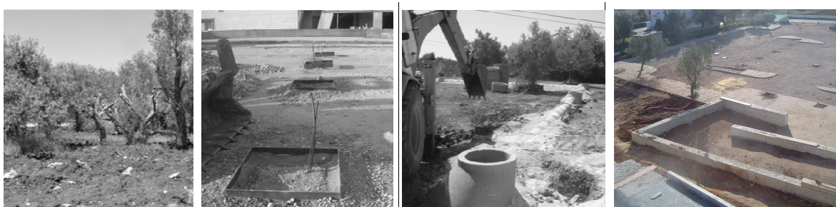
Fig. 3.27– Da esquerda para a direita: árvores transplantadas em local provisório; colocação de guias em caldeiras de árvores; instalação de rede de pluviais; construção de muros de contenção de rampas e espalhamento de sub-bases (Fotos: A.S.).
