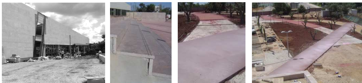
Fig. 3.28 - Da esquerda para a direita: colocação de caixilharias e envidraçados no edifício; execução de pavimentação do “átio” exterior; revestimento em brecha calcária de degraus; execução do pavimento em betão e pavimento em betão da diagonal (finalizado). (Fotos: A.S.).
