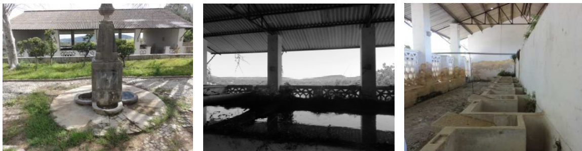
Fig. 3.56 - Da esquerda para a direita: Vista do Jardim para o Lavadouro (para sul) ; vistas dos contrafortes dos cerros calcários a partir do interior do edifício do lavadouro; interior do edifício do lavadouro e "bateria" de tanques de lavar . (Fotos: A.S).
