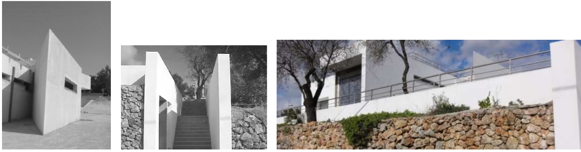
Fig. 3.47 – À esquerda, os materiais e acabamentos são os mesmos do edifício: muro de betão pintado de branco, conforma a entrada sul, escadaria com acabamento em lajetas de betão natural, guarda corpos em aço inox; à direita a rigidez e brancura dos muros de betão versus a organicidade da pedra solta e das árvores existentes. (Fotos:A.S).
