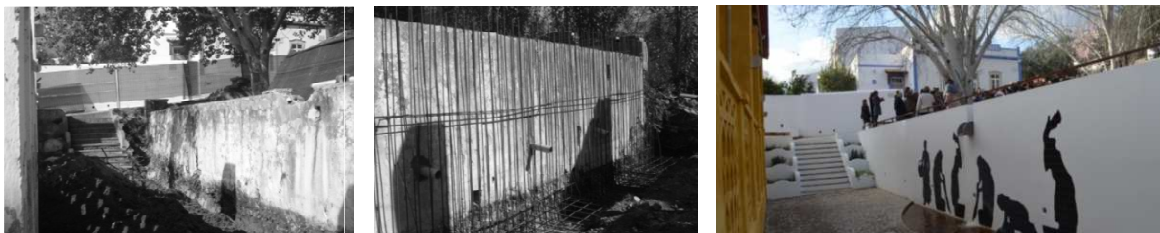
Fig. 3.64 - Aspecto dos trabalhos de recuperação e reforço do muro existente: início da obra, fase intermédia e fase final. (Fotos: A.S).
