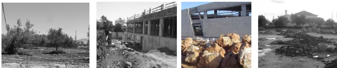
Fig. 3.26 – Da esquerda para a direita: vedação da obra e piquetagem; escavação para implantação do edifício; rochas retiradas da escavação em profundidade; escavação de valas para tubagem de pluviais. (Fotos: Filipe Sobral).
