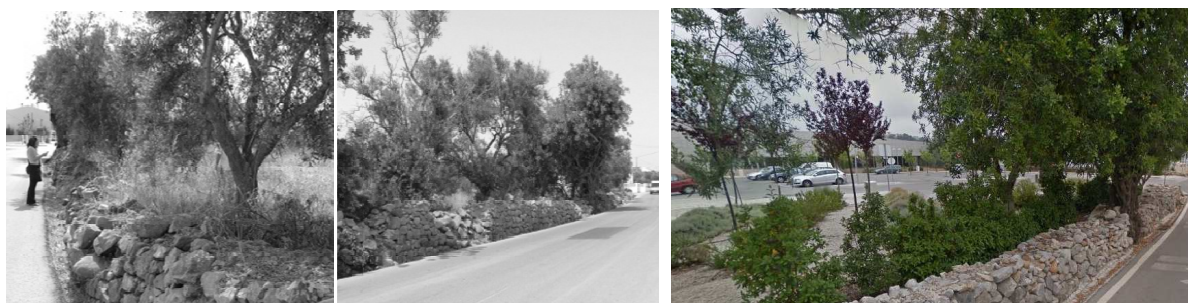
Fig. 3.30 – Da esquerda para a direita: muro/“valado” pré-existente em mau estado como limite de propriedade com alfarrobeiras e oliveiras; parte intermédia do muro colapsado; com a implementação do projecto, manutenção e recuperação das árvores e do valado e passeio pedonal do lado interior do terreno. (Fotos: A.S).
