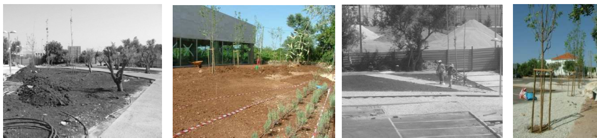
Fig. 3.29 - Da esquerda para a direita: Execução das micromodelações em áreas plantadas; preparação do terreno; plantações efectuadas e revestimentos colocados. (Fotos: A.S).
