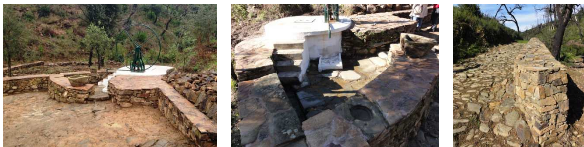
Fig. 3.52 - Vistas do conjunto após a obra e vista a partir do poço para o caminho de acesso e muro recuperados. (Fotos: Telma Rasquinho).
