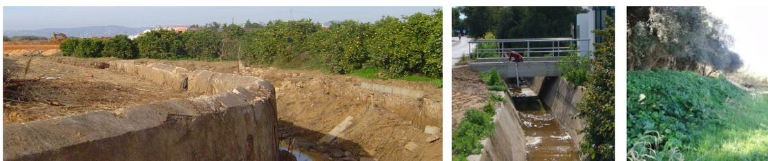
Fig. 1.27 – À esquerda, foto de troço da ribeira do Rio Seco, margem direita totalmente murada; ao centro, rib<sup>a</sup>. da Canada totalmente impermeabilizada e, à direita, margem da ribeira do Rio Seco com cômoro ou mota de altura significativa face aos terrenos marginais adjacentes. (Fotos: A.S, Foto do meio: Rui Lança)
