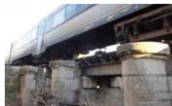
Fig. 1.38 - Obstrução de pontes e passagens hidráulicas por canas e outros detritos (neste caso, ponte da REFER). (Foto: A.S.).
