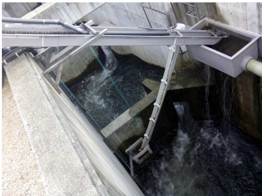
Figura 20 - Sistema de air lift da PPEnguias, conectando a décima quinta bacia da PPPeixes e a sétima bacia da PPEnguias
