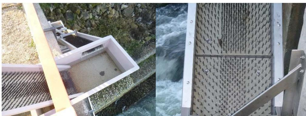
Figura 15 - Bacia de descanso (à esquerda) e caleira com substrato artificial (à direita) da PPEnguias
