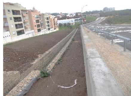
Fig. 8 Fotografia dos gabiões na área de intervenção (Fonte: Autor)
