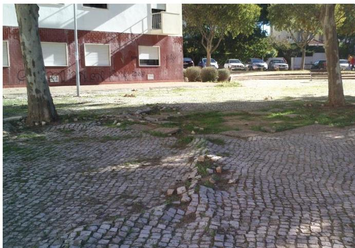
Fig. 21 Fotografia de parte da área com calçada degradada devido às raízes dos Plátanos (Fonte: Autor)
