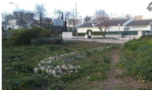
Fig. 35 Fotografia onde são visíveis as pedras utilizadas para facilitar a drenagem do local (Fonte: Autor)
