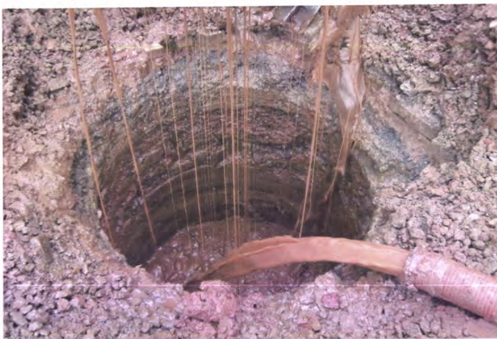
Figura 5.4 - Aspecto viscoso do polímero e paredes da escavação revestidas.
