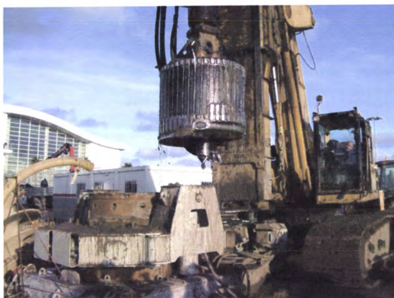
Figura 3.3 – Perfuratriz com torno hidráulico incorporado.
