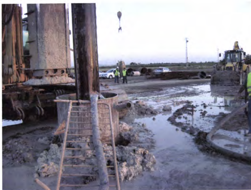
Figura 2.7 - Perfuração com uso de tubo guia e fluido de estabilização.
