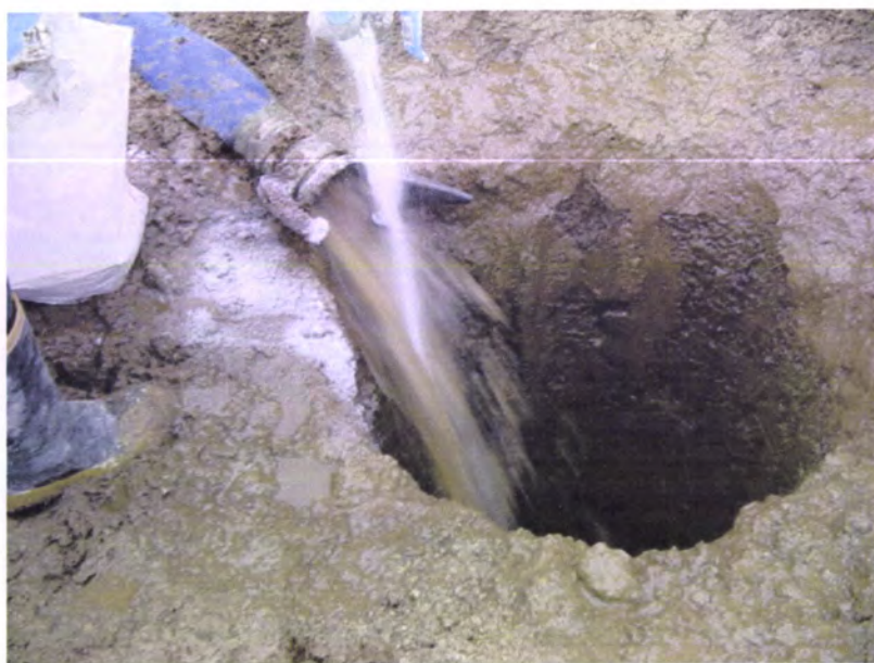
Figura 6.17 - Mistura directa do polímero à boca da escavação.
