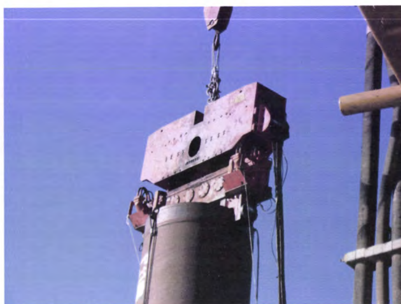
Figura 3.4 – Vibrador acoplado ao topo da camisa metálica.
