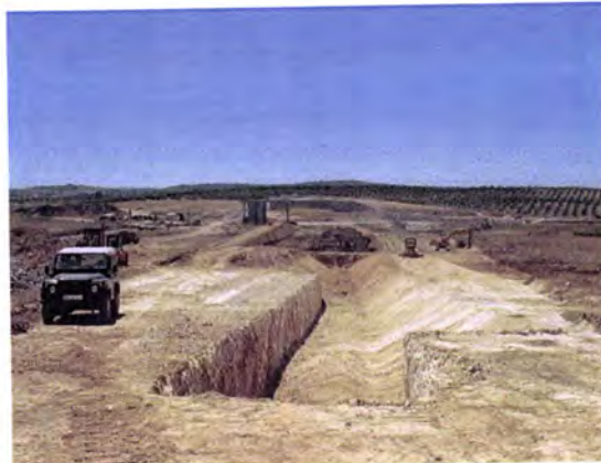
Fotografia 5: Escavação da vala corta-águas. Encontro direto em material de “caliço”.
