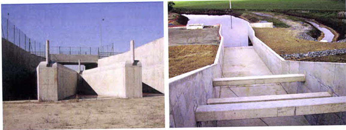
Fotografia 1: Vista de montante e para jusante do descarregador de superfície.
