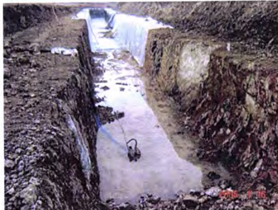
Fotografia 3: Conduta da tomada de água. Vista Geral da escavação da vala, observando-se as aflúncias de água provenientes do maciço de fundação do encontro esquerdo.
