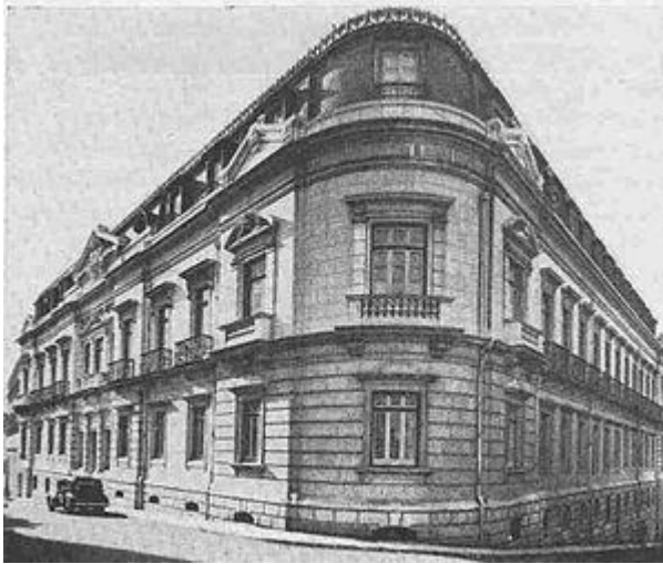
Anexo I - Antigo edifício do Conservatório Nacional, hoje sede da Escola de Música do Conservatório Nacional
