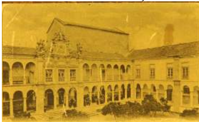
Figura 1: Recanto do claustro antes da demolição do salão da Casa Pia
