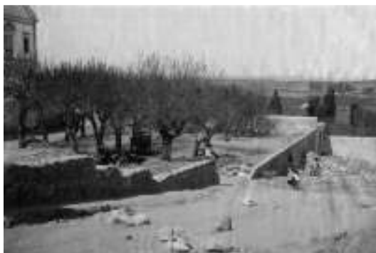
Figura 9: construção da defesa ao pátio contíguo ao pórtico do liceu confrontante com a atual Rua do Cardeal Rei
