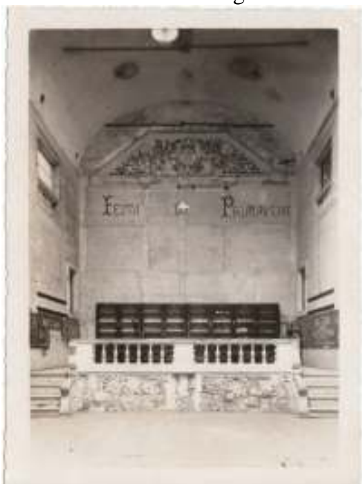
Figura 12: A Sala dos Atos antes de ser transformada em ginásio
