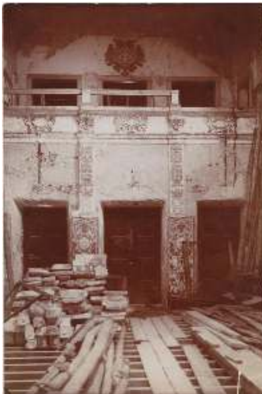
Figura 6: O desmantelamento da sala dos atos
