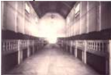
Figura 10: Sala dos atos depois de concluída a 1ª fase do restauro
