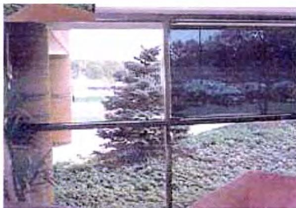
**Figura 2.28** - Janela electrocrómica de área  $1 \times 2\text{m}^2$ , com o painel superior direito electroactivado. Os outros três painéis permanecem num estado inactivo. (Adaptado de Monk *et al.*, 2007).
