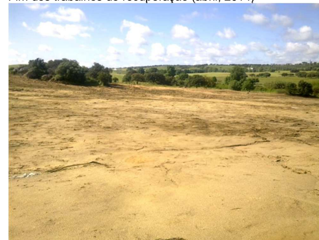
Fim dos trabalhos de recuperação (abril, 2014)
