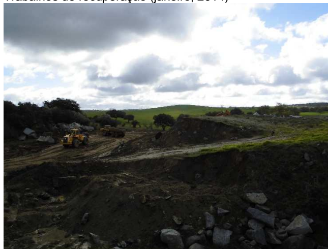
Trabalhos de recuperação (janeiro, 2014)
