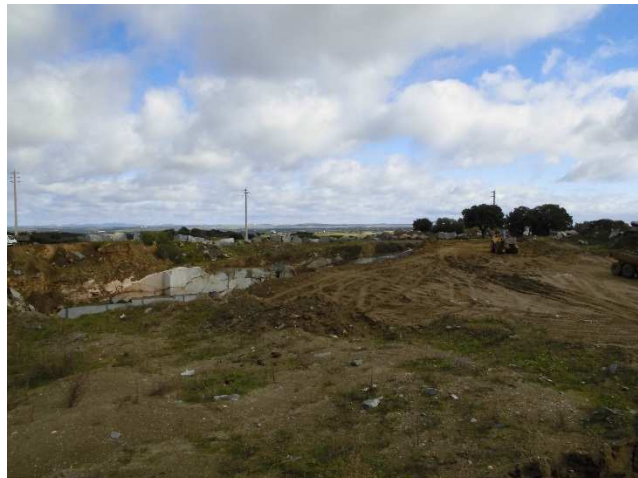
Trabalhos de recuperação (janeiro, 2014)
