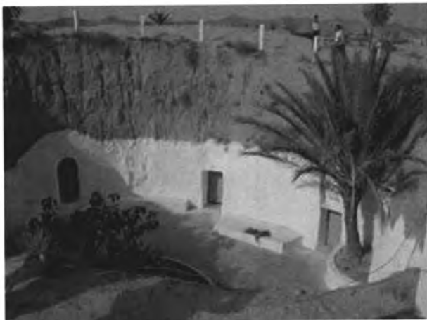
Figura 24 - Terra Escavada na vertical, Tunísia
