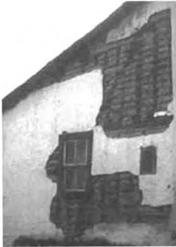
Figura 32 - Parede em Tabique, Fundão.
