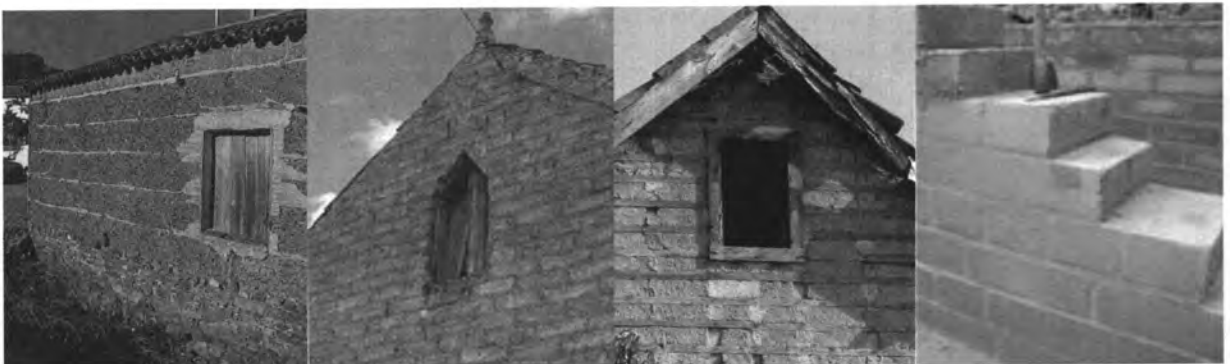
Figura 27 - Quatro técnicas de construção em terra, da esquerda para a direita, Taipa, Adobe, Tabique e Blocos de Terra Compactada
