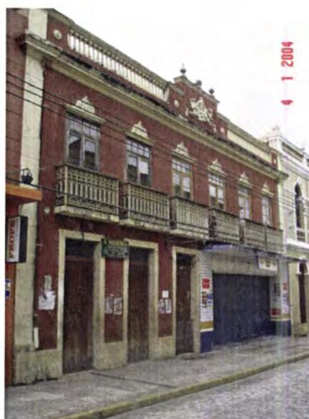
**Figura 5-21:** São Luís. Rua Grande. Construção em estilo eclético. Observa-se a alteração dos vãos originais por outros maiores, fechados com portas metálicas de enrolar, 2004.
