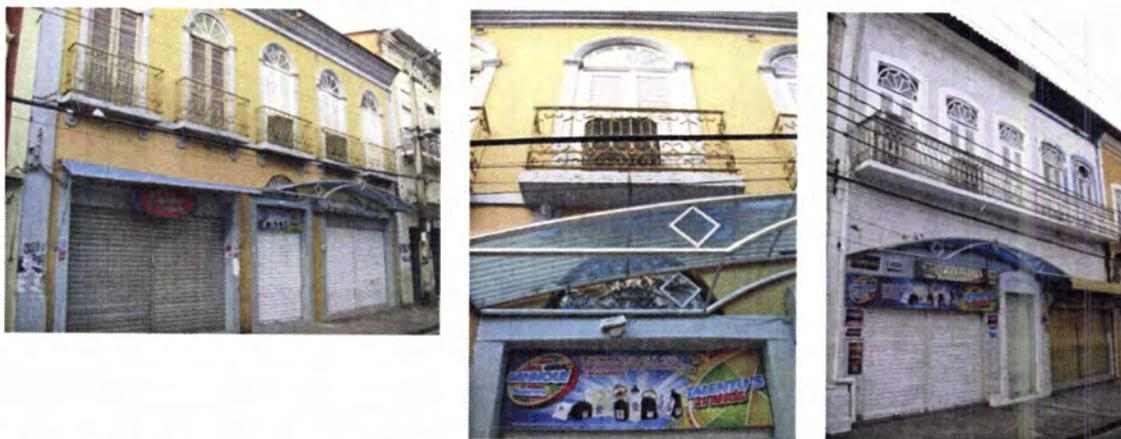
Figura 7-36: São Luís. Rua Grande. Instalação de toldos fora do padrão, interferindo na fachada e escondendo elementos originais característicos, 2009.
