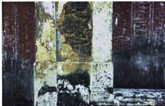
**Figura 6-2: São Luís. Rua do Giz. Detalhe de fachada de sobrado com alvenaria em pedra, década de 1990.**
