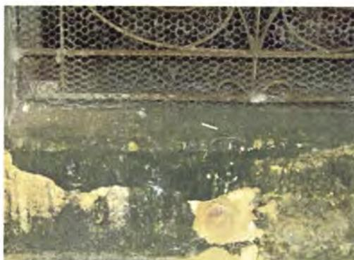
**Figura 7-21: São Luís. Rua Grande. Local de retirada da amostra Ac, à superfície, com visível presença de fungos, 2004.**
