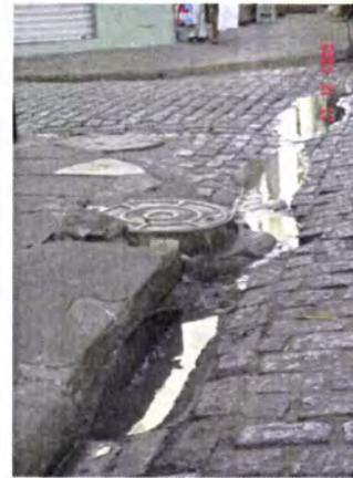
**Figura 7-10:** São Luís. Rua Grande. Exemplo de calçamento danificado e obstrução da tubulação de esgotos, 2003.
