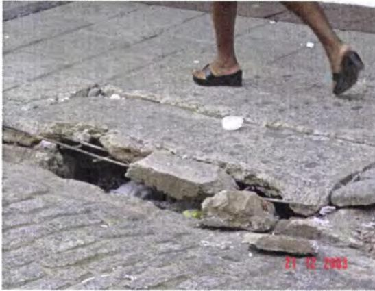
**Figura 7-9:** São Luís. Rua Grande. Boca de lobo para escoamento de águas pluviais completamente destruída, 2003.
