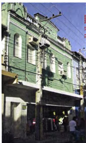
**Figura 7-1: São Luís. Rua Grande. Exemplo de uso inadequado de aparelhos de ar-condicionado, alterando as características originais da fachada, 2004.**
