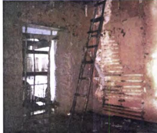
**Figura 6-6:** São Luís. Rua da Estrela. Reboco com alvenaria mista de taipa de mão e pedra, 2000.
