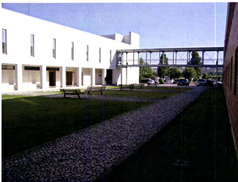
Edifício O, com Jardim Exterior
