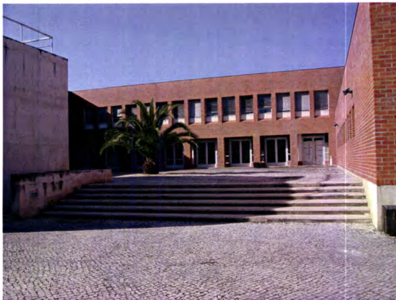
Edifício B, com Pátio Exterior
