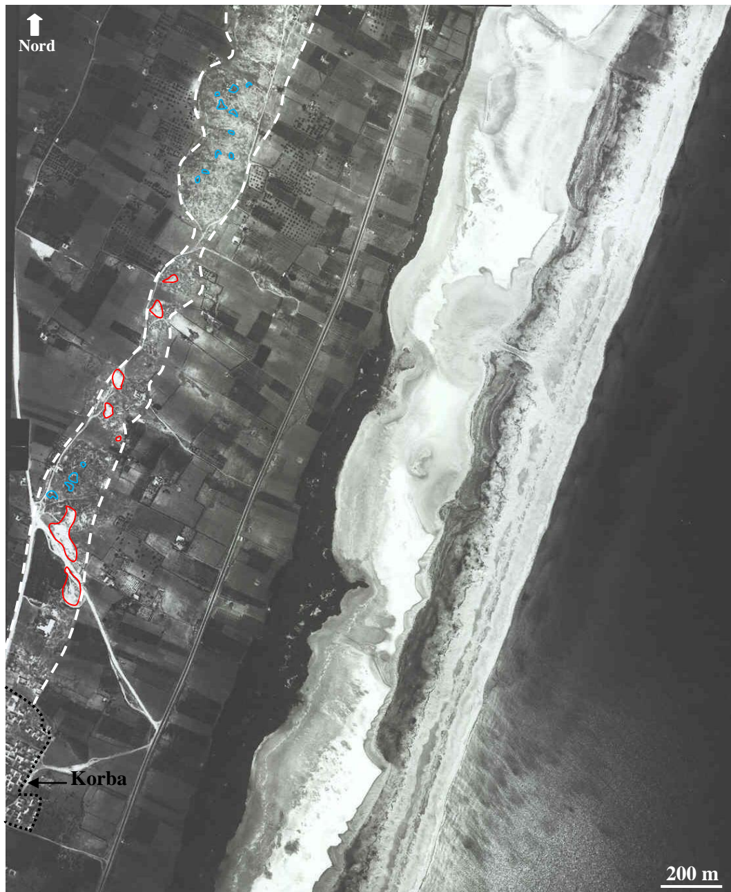
Figure 34: Photo aérienne de la mission de 1962 couvrant la partie nord de Korba et le cordon littoral au niveau de sa partie attenante à la ville. Les carrières en activité, marquées en rouge, sont rares et de taille limitée ; le trait blanc tireté donne la délimitation du cordon tyrrhénien. Les zones en bleu correspondent à des carrières non actives et dont une partie, au moins, date de l'Antiquité.
