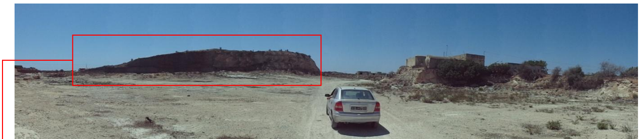
Figure 81: Des fronts de taille portant des traces variées. Celui à droite, dont le sommet est occupé par des habitations abandonnées, porte les traces d'une extraction à la dynamite. Celui à gauche porte des traces de scie mécanique. On note aussi le caractère régulier de la topographie du fond de la carrière (C. Weslati, août 2014).
