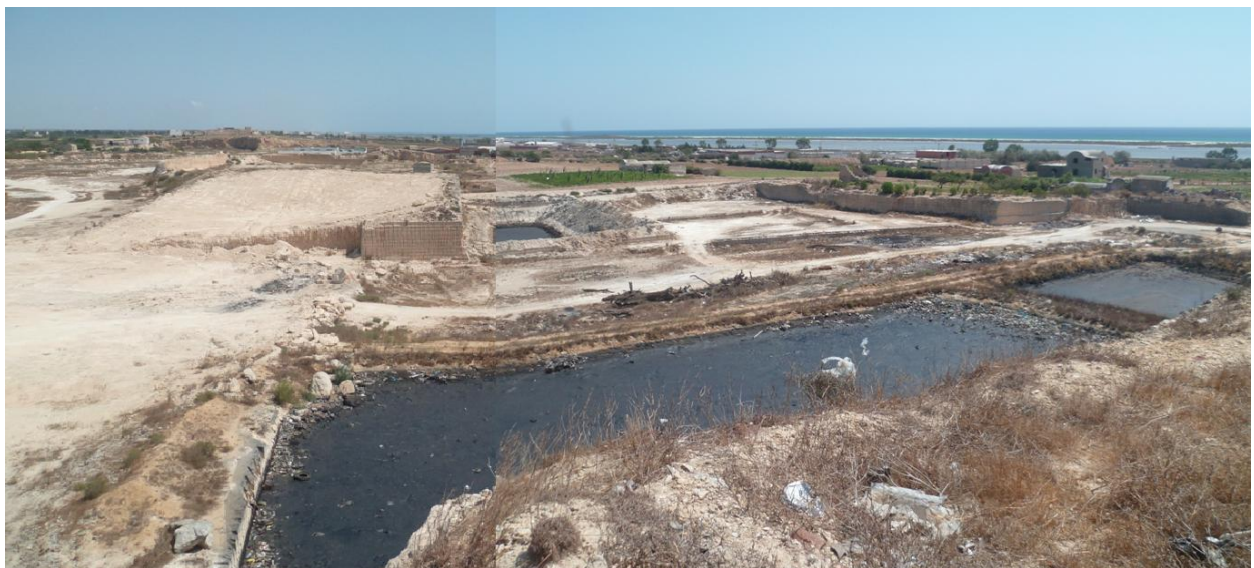
Figure 86: Grands bassins de stockage de margine creusés au fond des carrières de la sortie nord de Korba. On aperçoit, au second plan, la lagune de Korba (C. Weslati, août 2013).
