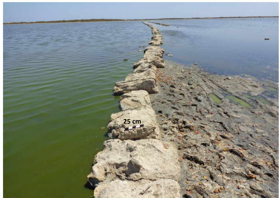
Figure 22: Exemples de chaussées romaines traversant la lagune de Korba; les blocs proviennent du cordon tyrrhénien. On distingue, au dernier plan, l'un des sites archéologiques de bord de mer (site 4) indiqué par la topographie plus haute que le reste de la plage (C. Weslati, août 2014).
