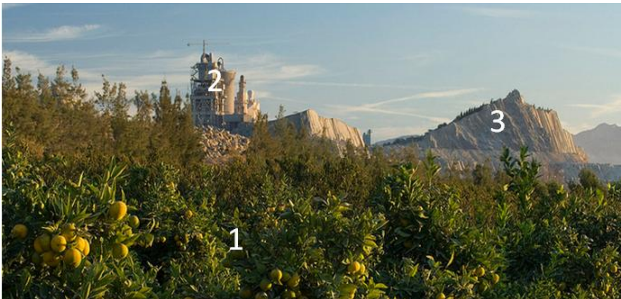
Figure 77: Les 3 éléments du nouveau paysage: la ferme (1), l'usine (2) et le front de taille de l'ancienne carrière (3) ( https://www.flickr.com/photos/cemexspain/13264890605/in/album-72157642586504895/ ).
