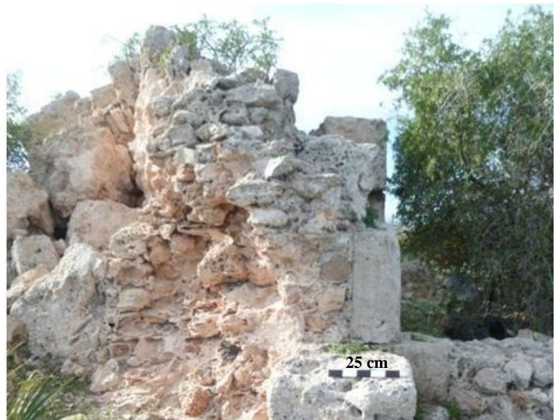
Figure 20: Détails de murs antiques montrant les différents usages de la pierre chekhech : en moellons et en gros blocs taillés (C. Weslati, décembre 2013).
