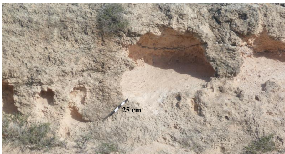
Figure 27 : Cavités formées dans le front de taille d'une petite carrière ancienne au niveau de la sortie nord de Korba (C. Weslati, août 2014).
