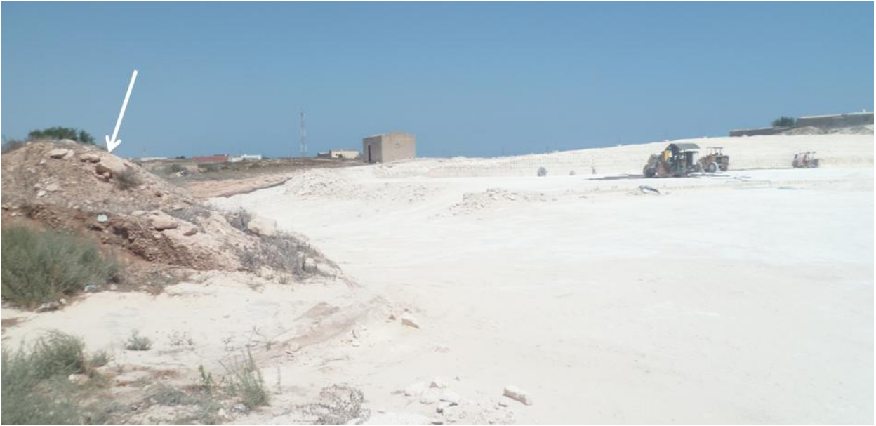
Figure 96: Premiers travaux dans la création d'une nouvelle carrière. On reconnaît le sol naturel accumulé en bordure de la zone à exploiter (indiqué par la flèche). Malheureusement, très souvent ce sol finit par être dispersé avec l'avancement de l'exploitation (C. Weslati, août 2014).
