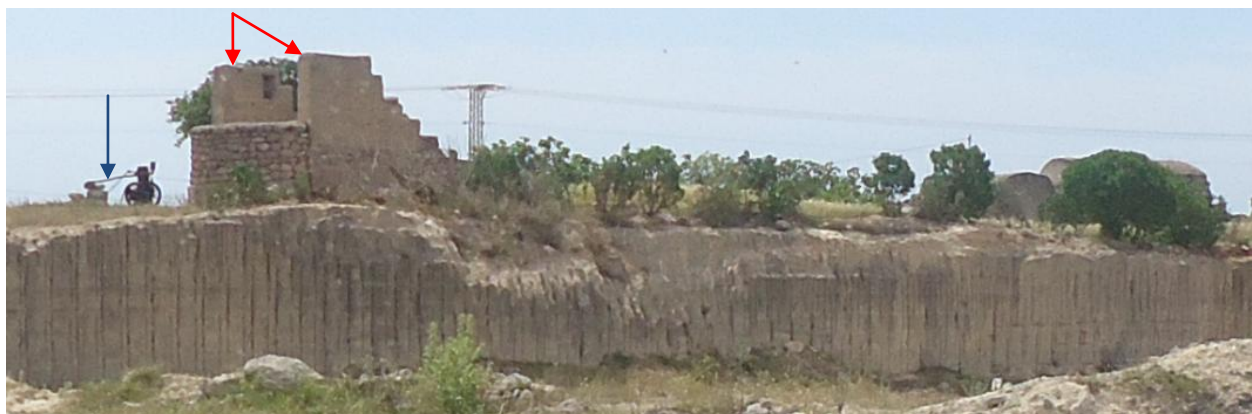
Figure 85: Un puits situé au contact d'une carrière exploitée à la scie mécanique. Il se caractérise par ses « ailes » indiquées par des flèches rouges et constitue un témoin de l'ancienne technique d'extraction de l'eau. Aujourd'hui, la place est donnée à la motopompe indiquée par la flèche bleue (C. Weslati, mai 2014).
