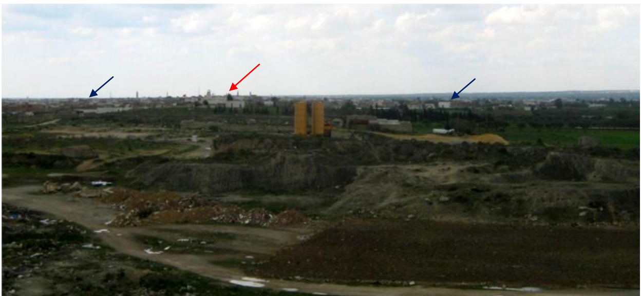
Figure 52: Vers le Sud: photo prise dans l'axe du cordon tyrrhénien en direction de la ville de Korba et montrant le front de constructions en progression en direction de la zone des carrières. Le premier noyau de la ville est érigé au sommet du cordon (flèche rouge), l'espace bâti commence à s'étendre aussi aux dépens des terres agricoles (flèches bleues) (C. Weslati, mai 2014).
