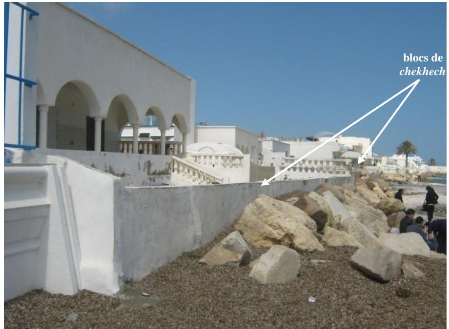
Figure 37: Exemple de digue de protection contre l'érosion marine à Kelibia utilisant, en partie, de gros blocs chekhech (C. Weslati, décembre, 2013).
