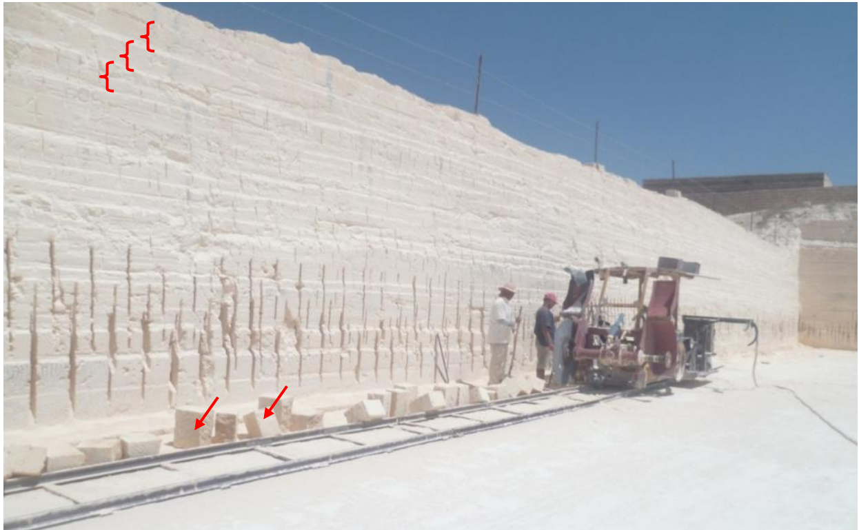
Figure 40: Extraction de pierre à la scie mécanique dans le secteur des Ayayda : des parois régulières et une profondeur importante. Le front de taille porte différentes traces permettant d'avoir une idée sur l'épaisseur des assises (accolades). Quelques blocs extraits sont visibles à côté du rail (flèche) (C. Weslati, août 2014).
