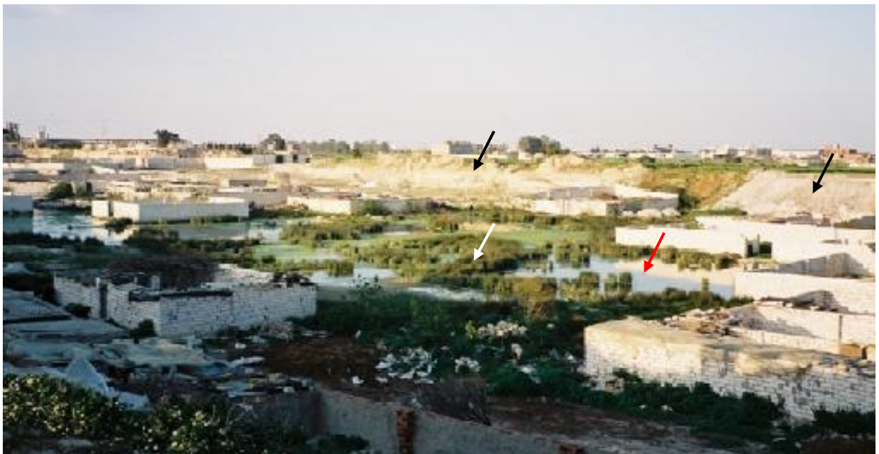
Figure 67: Un vrai quartier en formation au fond de la carrière d'el Bouheira à Rejiche. On voit bien le front de taille (flèches noires) qui sert désormais comme limite de la cuvette formée suite à l'exploitation, ainsi que l'affleurement de la nappe phréatique (flèche rouge) et la végétation d'eau douce (flèche blanche) (Belgacem, 2007).
