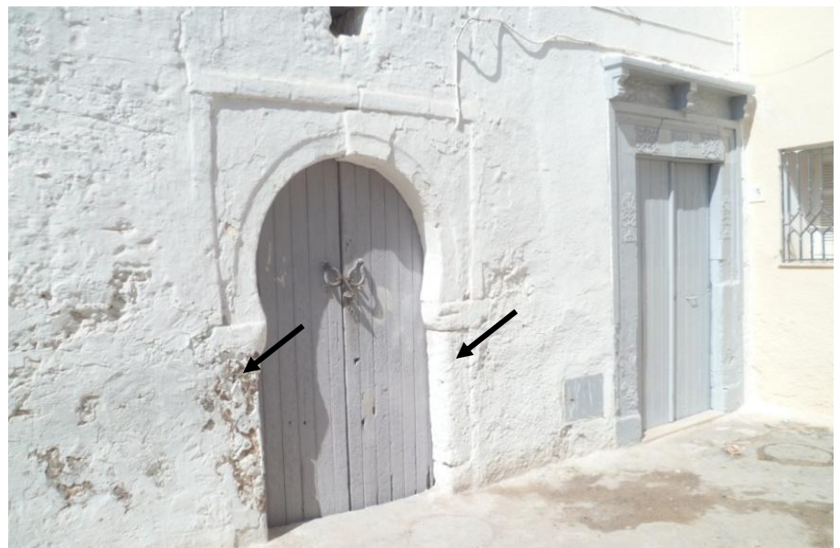
Figure 24: Exemples de façades d'habitations du vieux noyau islamique de la ville de Korba. Les gros blocs (indiqués par des flèches) matérialisant les bordures des entrées proviennent du cordon tyrrhénien (C. Weslati, août 2014).
